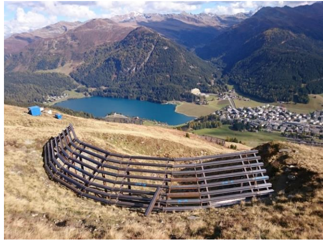
Stützverbau oberhalb Davos
