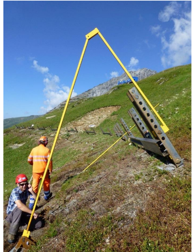
Abb. 5 (oben links): Prüfung des Tragwiderstandes der Anker. Abb. 6 (oben rechts): Einmessen der Stützen mit Abstecklehre.
