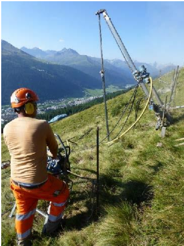
Abb. 1. (links): Ankerbohrungen bei guten Verhältnissen. Abb. 2. (oben): Frisch erstellter Anker an der Absteckungslinie.
