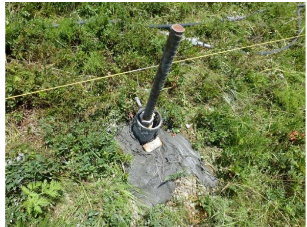
Abb. 1. (links): Ankerbohrungen bei guten Verhältnissen. Abb. 2. (oben): Frisch erstellter Anker an der Absteckungslinie.
