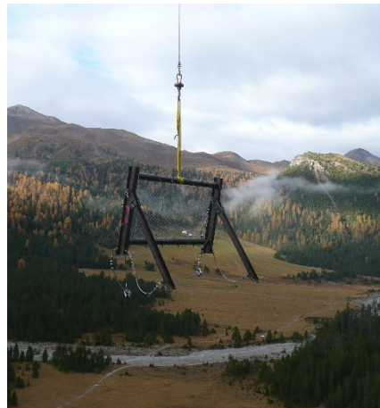
Abbildung 4: Element am Lasthaken des Helikopters
