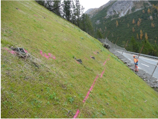
Abbildung 1: Für Helikoptermontage vorbereitete und markierte Ankerplatten; im Hintergrund Steinschlagschutz Kantonsstrasse
