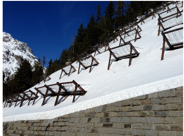
Abbildung 9: SNOWSTOP-G „im Betrieb“
