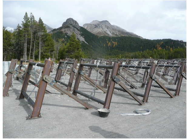
Abbildung 2: Vormontierte Elemente auf dem Installationsplatz
