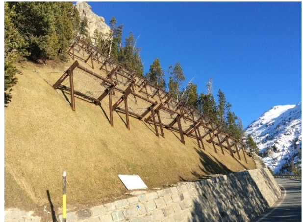
Abbildung 10: Blick von der Kantonsstrasse ins Verbauungsgebiet (fobatec 2015)
