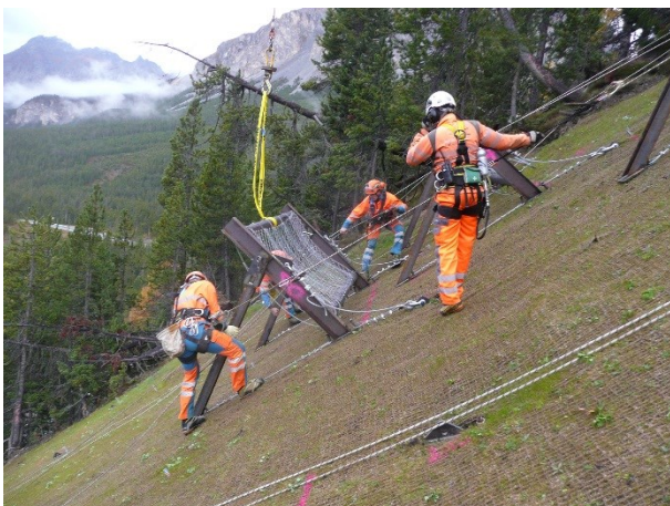
Abbildung 5: Helikoptermontage, d.h. Fixieren der Drahtseile an den Anker
