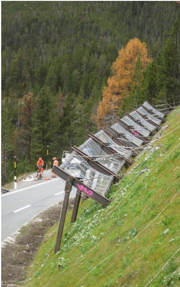
Abbildung 8: Unterste fertiggestellte Werkreihe
