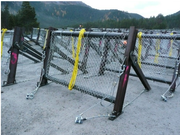
Abbildung 3: Für die Helikoptermontage vorbereitetes Element
