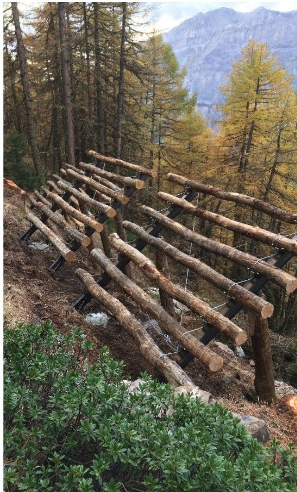
Abbildung 21: Die Brückenhölzer werden mit dem gespannten Befestigungsseil fixiert (Torrent, Leukerbad 2014)
