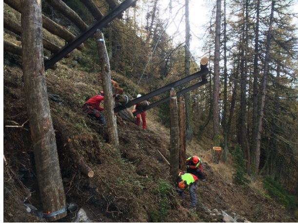
Abbildung 18: Der Rahmen wird auf die vorbereiteten Boden- und Stützenplatten aufgesetzt (Torrent, Leukerbad 2014)
