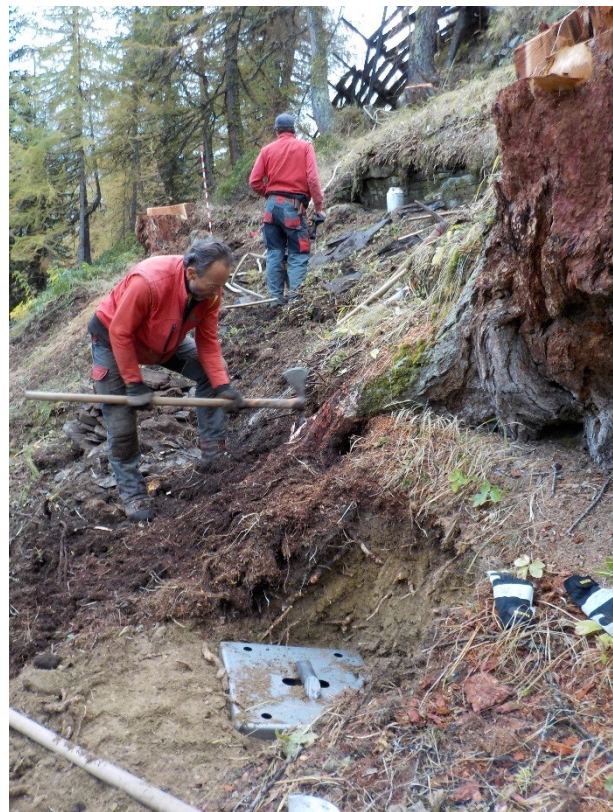
Abbildung 16: Vorbereitete Stützenplatte mit Aufsetzdorn im Vordergrund (Torrent, Leukerbad 2014)
