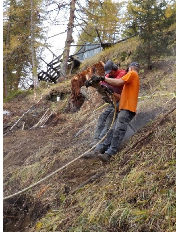
Abbildung 14: Vorbohren der Ankerlöcher für die Zuganker (Torrent, Leukerbad 2014)
