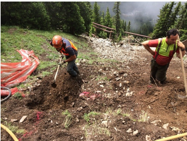
Abbildung 11: Ausheben der Fundamente für die Bodenplatten (Seehorn, Davos 2014)
