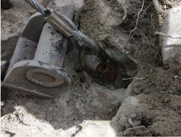
Abbildung 17: Detailansicht zum vorbereiteten Erdnagel und bergseitigem Zuganker (Seehorn, Davos 2014)
