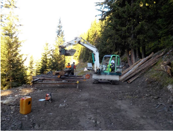
Abbildung 7: Vormontage der Brückenträger mithilfe eines kleinen Fahrbaggers (Seehorn, Davos 2014)
