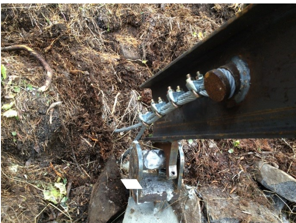
Abbildung 20: Mit Schwernspannstift gesicherter Brückenträger und mit Seilklemmen fixiertes Ankerseil (Seehorn, Davos 2014)
