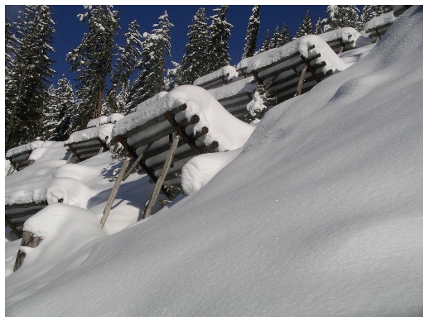
Abbildung 6: Inhomogene Schneedecke durch das Abstützen mit den rempar grischun (Januar 2011)
