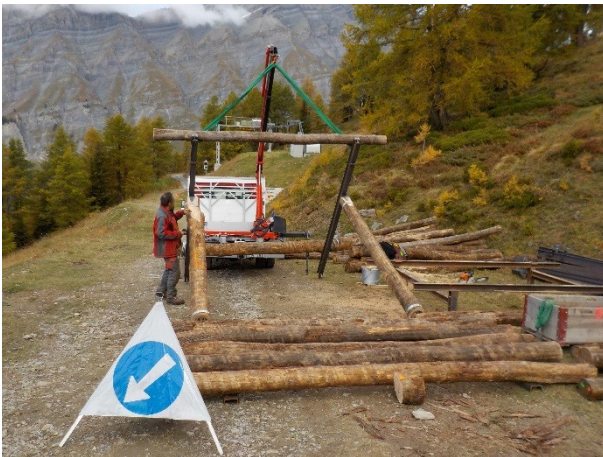
Abbildung 9: Transporter mit Kranarm zur Vormontage der repar grischun Rahmen (Torrent, Leukerbad 2014)
