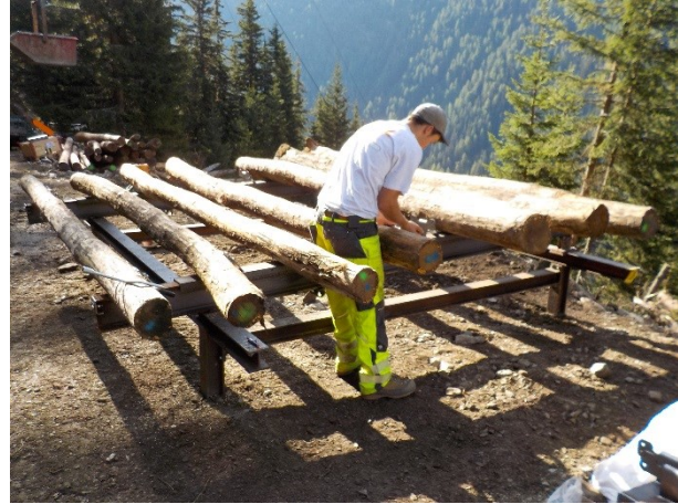
Abbildung 8: Bestücken des Brückenträgers mit den Rosthölzern auf dem Installationsplatz (Seehorn, Davos 2014)
