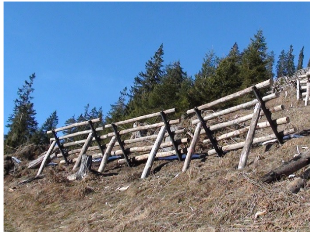
Abbildung 4: Bergwärtiger Blick mit Ansicht unter die rempar grischun Werke (Dezember 2013)
