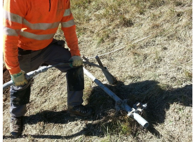
Abbildung 14: Verpressen des Ankermörtels von unten nach oben, bis dieser aus dem Bohrloch hervorquillt
