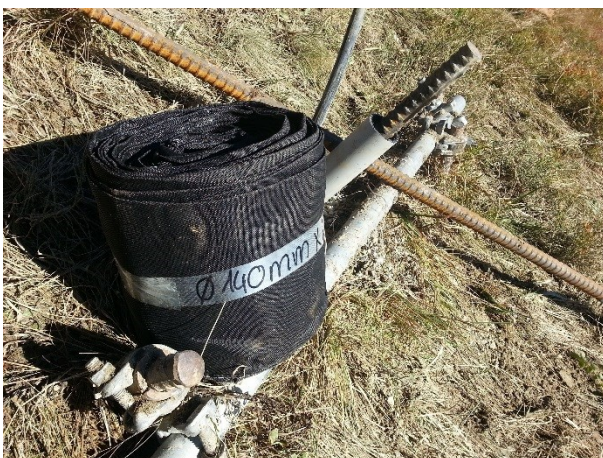
Abbildung 11: Ankerstrumpf gegen unkontrolliertes Wegsickern des Mörtels; hier Strumpf HATE 140 mm
