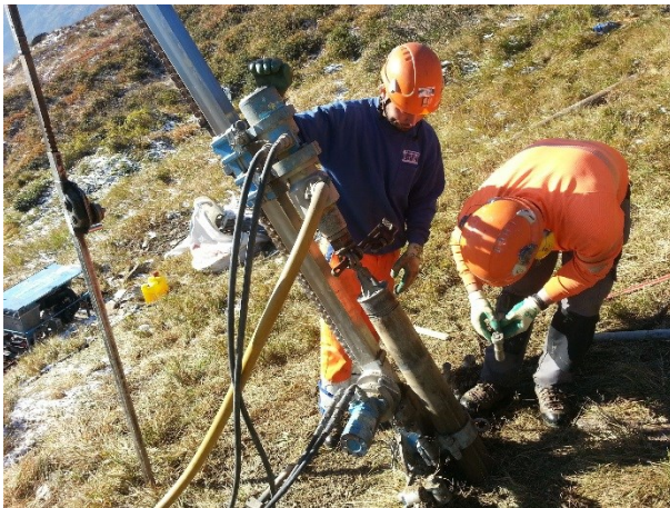
Abbildung 9: Die Verrohrung wird nach dem Versetzen des Stabankers wieder ausgezogen
