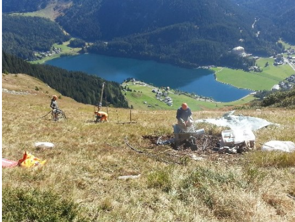
Abbildung 13: Mischen des frischen Ankermörtels zur anschliessenden Vermörtelung der Stabanker
