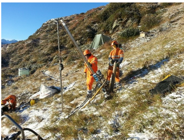
Abbildung 5: Die fertig vormontierte Bohrlafette ist bereit für die Bohrarbeiten
