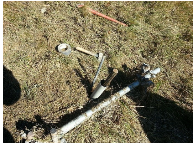
Abbildung 10: Über Stabanker gestülpte Hüllrohre ermöglichen die für Ausziehversuche geforderte freie Ankerlänge von 1 m
