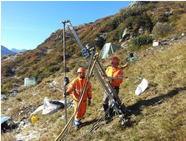
Abbildung 7: Eintreiben der Verrohrung bis zur nötigen Einbindetiefe des Ankers
