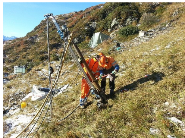
Abbildung 6: Anbringung einer Verlängerung an die Verrohrung (Stoss), um die zu erzielende Ankerlänge zu erreichen
