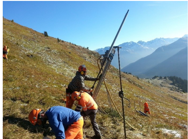
Abbildung 8: Versetzen des GEWI-Stabankers in das verrohrt vorgebohrte Bohrloch (oberste Meter mit Hüllrohr versehen)
