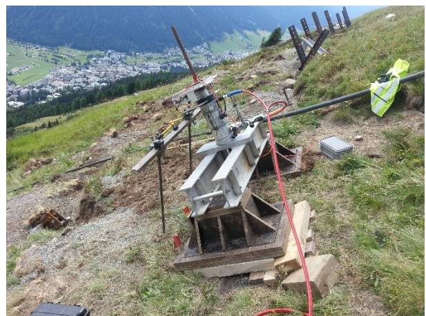
Abbildung 18: Zugprobe am Prüfanker 2 zur Qualitätsprüfung der versetzten Zuganker in der Erweiterung der LV Dorfberg
