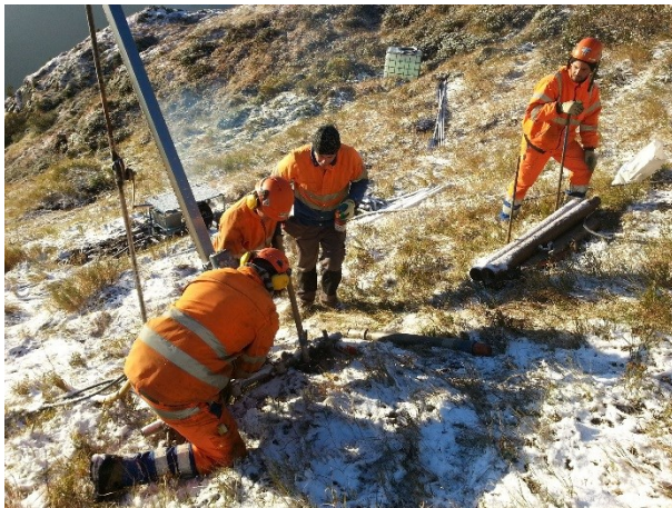
Abbildung 3: Vor den Bohrarbeiten muss die Bohrlafette korrekt installiert bzw. fixiert werden
