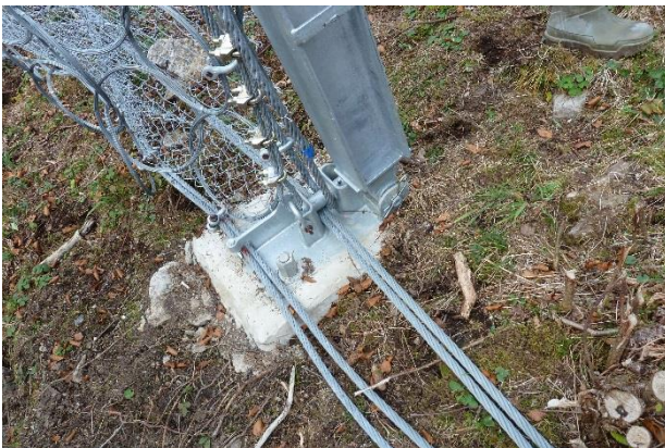
Abb. 11: Fertig ausgeführtes Stützenfundament mit montierter Stütze (Foto: H. Richener).
