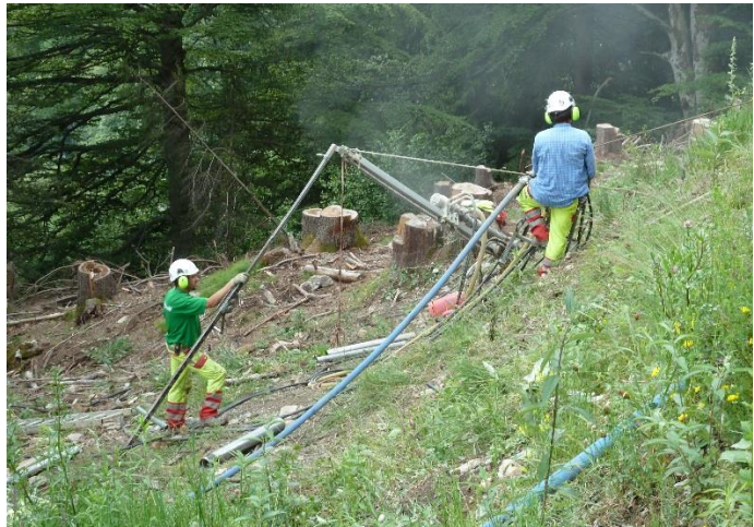
Abb. 1: Bohrungsarbeiten mit einem Bohrgerät mit Imlochhammerausrüstung und Luftspülung (Bild: H. Richener).
