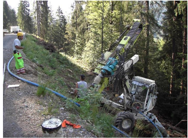
Abb. 7: Schreitbagger mit Anbaulafette für Ankerbohrungen nahe an der Erschliessung (Foto: H. Richener).
