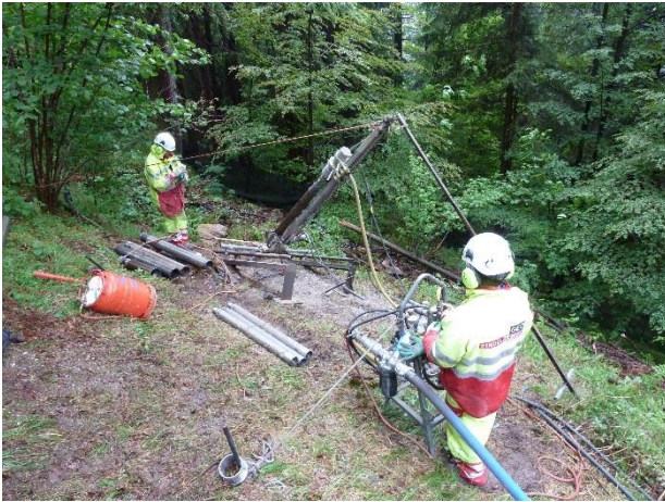
Abb. 6: Bohren mit dem Lawinenbohrgerät mit Imlochhammerausrüstung (Foto: H. Richener).
