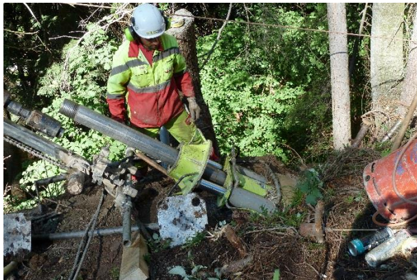
Abb. 8 (oben): Vermag die Lafette die Verrohrung nicht aus eigener Kraft aus dem Borhloch ziehen, muss diese mit Hilfe von Hydraulikzylindern herausgezogen werden (Foto: H. Richener).
