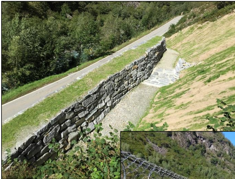
Abbildung 12 Vollendete Massnahmen: Blockmauer umrahmter Schutzdamm und im Hintergrund die Schutznetze sowie ältere Palisaden aus Holz. TBA GR
