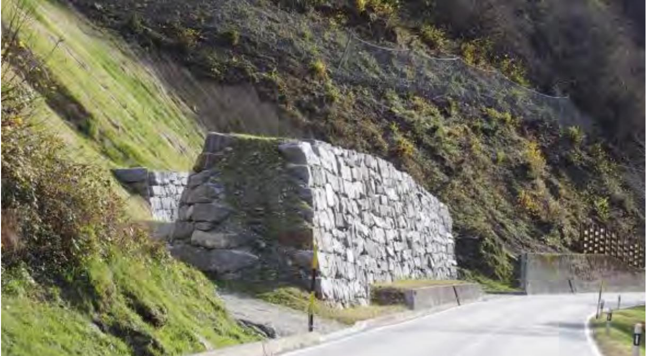
Abbildung 12 Vollendete Massnahmen: Blockmauer umrahmter Schutzdamm und im Hintergrund die Schutznetze sowie ältere Palisaden aus Holz. TBA GR
