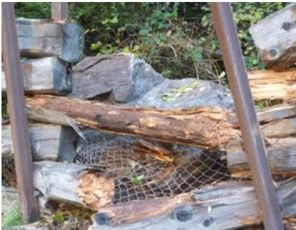
Abbildung 8 a und b Blöcke weisen nur einzeln Grössen über 0.25 \text{ m}^3 auf, bis maximal 1.0 \text{ m}^3 .
