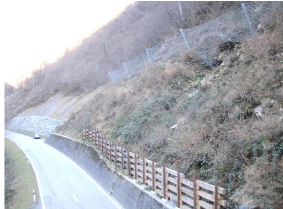
Diga, reti di protezione e vecchie palizzate sulla strada cantonale 741
