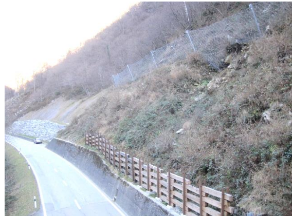
Damm und Netze, sowie ältere Palisaden an der Kantonsstrasse 741
