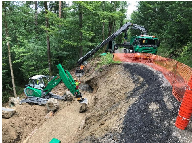
Holzkasten zur Hang- und Strassenstabilisierung (Bild: C. Zollinger)
