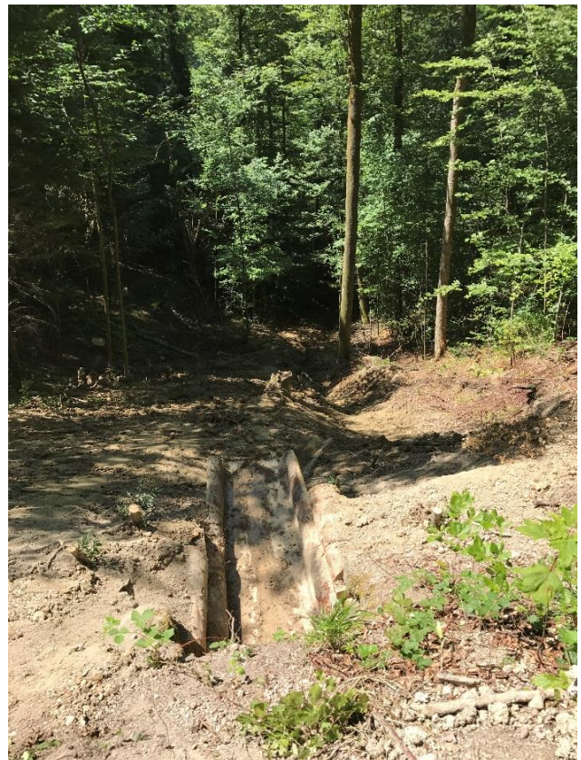
Abb. 9: Neue Wasserführung nach der Durchlassöffnung mit Sickerkies /-beton unter den «Känel» (nicht sichtbar).
