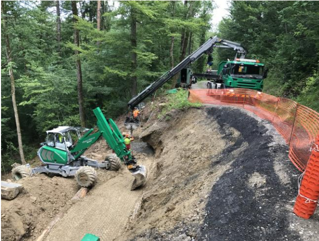
Abb. 5: Die Verfüllung wurde mit Kleinmaschinen verdichtet, um einerseits Setzungen innerhalb des Holzkastens gering zu halten, andererseits um das spezifische Gewicht zu erhöhen.
