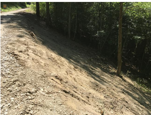
Abb. 8: Der Holzkasten wurde mit der ursprünglichen Böschungs- neigung vollständig eingedeckt.
