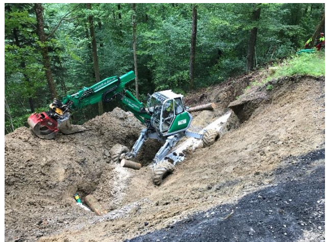
Abb. 4 (oben): Zudecken und Verdichten der ersten Holzlage.
