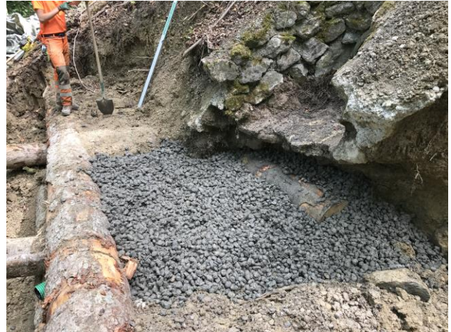
Abb. 6: Sickerbeton im Bereich der Durchlassmündung, um hydraulischen Staudruck zu verhindern.
