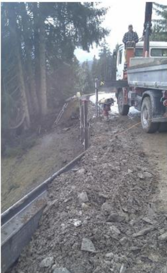
Figure 13, 14 & 15 : G : Remblayage de la paroi de pieux ancrés ; M : Montage de poteaux de barrière ; D : Corps de chaussée nouvellement aménagé
