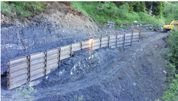
Figure 12 : Tronçonnage des pieux verticaux
