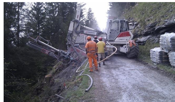
Abbildung 7: Bohrarbeiten vom bestehendem Strassenkörper
