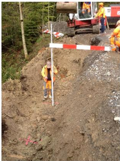
Figures 6, 7 & 8 : G : Déterminer la position de la semelle de la paroi ; M : Positions marquées des trous de forage ; D : Travaux de forage pour des pieux verticaux
