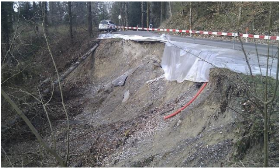
Figure 4: Mesures immédiates d'évacuation des eaux
