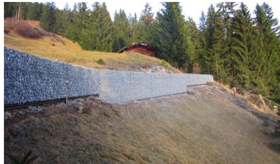
Figure 13 : Revêtement en gabions pour une valorisation optique (breveté par Ribbert AG)
