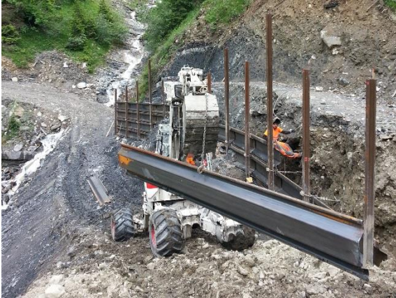
Abbildung 8: Montage der Ausfachung (Larssen)
