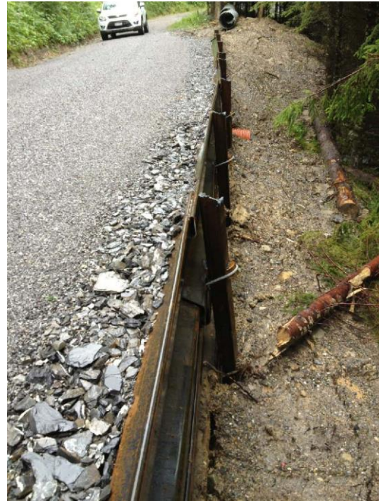
Verankerte Pfahlwand, (Gommiswald)
