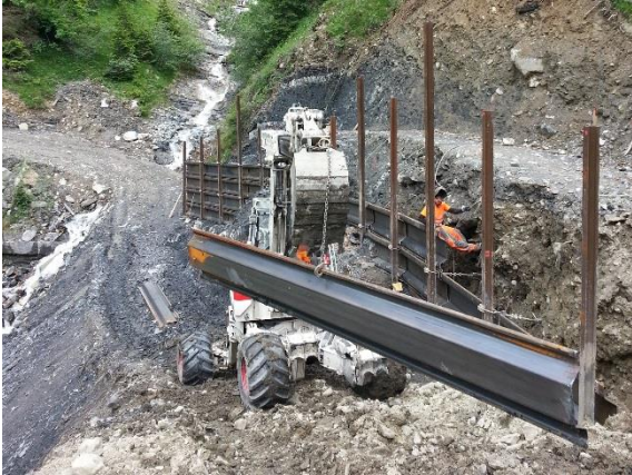
Figure 10 : Montage du remplissage (palplanches)
