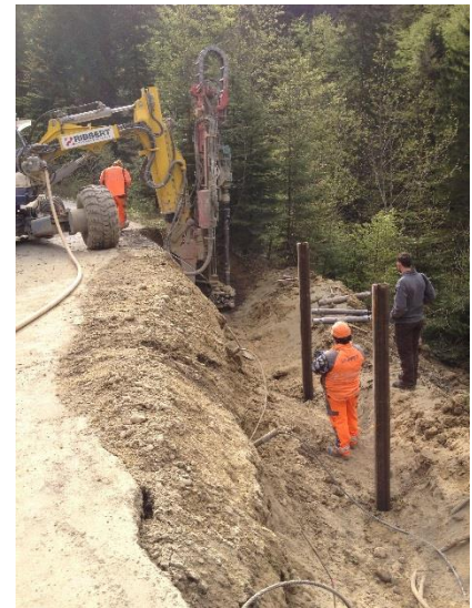
Abbildung 5: Bohrarbeiten für vertikale Pfähle
