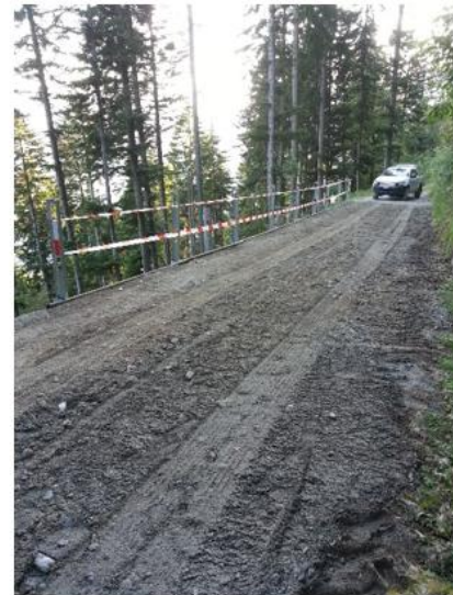
Figure 13, 14 & 15 : G : Remblayage de la paroi de pieux ancrés ; M : Montage de poteaux de barrière ; D : Corps de chaussée nouvellement aménagé
