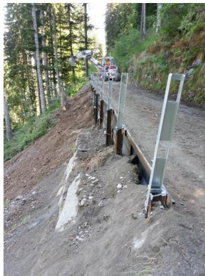
Abbildung 13: Montage von Bündnerzaun-Pfosten
