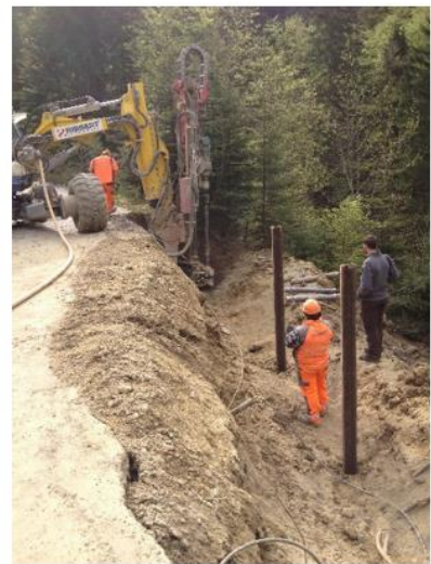
Figures 6, 7 & 8 : G : Déterminer la position de la semelle de la paroi ; M : Positions marquées des trous de forage ; D : Travaux de forage pour des pieux verticaux
