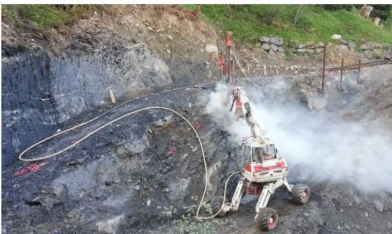
Figure 8 : Travaux de forage à partir de la piste de construction
