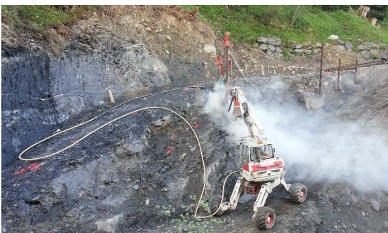
Abbildung 6: Bohrarbeiten von Baupiste aus
