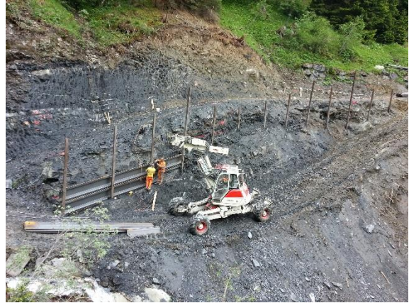
Abbildung 9: Montage der Ausfachung (Larssen) und der Rückverankerung
