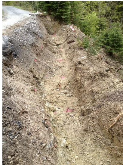
Abbildung 4: Markierte Positionen der Bohrlöcher
