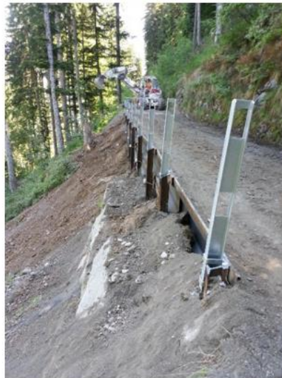
Figure 13, 14 & 15 : G : Remblayage de la paroi de pieux ancrés ; M : Montage de poteaux de barrière ; D : Corps de chaussée nouvellement aménagé
