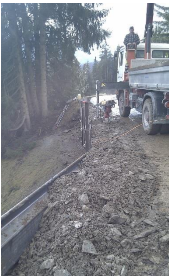
Abbildung 12: Hinterfüllung der verankerten Pfahlwand
