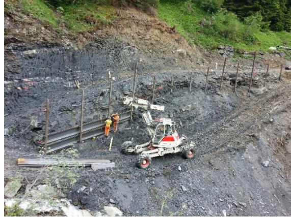
Figure 11 : Mise en place du remplissage et de l'ancrage arrière
