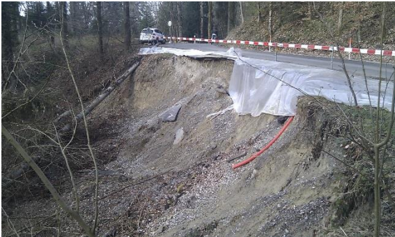
Abbildung 1: Sofortige Entwässerungsmassnahmen
