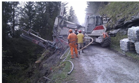
Figure 9 : Travaux de forage à partir de la route existante
