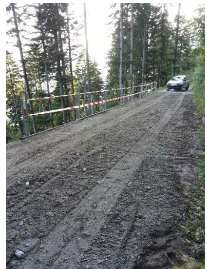
Abbildung 14: Neu ausgebildeter Strassenkörper
