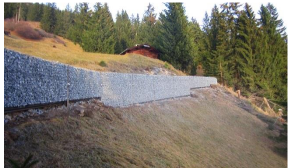
Abbildung 11: Gabionenverkleidung zur optischen Aufwertung (Patentiert durch Ribbert AG)
