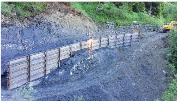
Abbildung 10: Ablängen der vertikalen Pfähle
