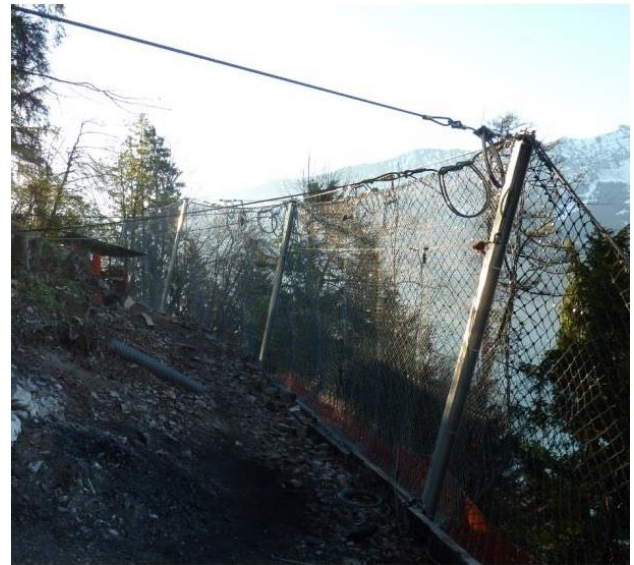
Abb. 8: Fertig montiertes Steinschlagschutznetz, Foto vom 20.3.2014.
