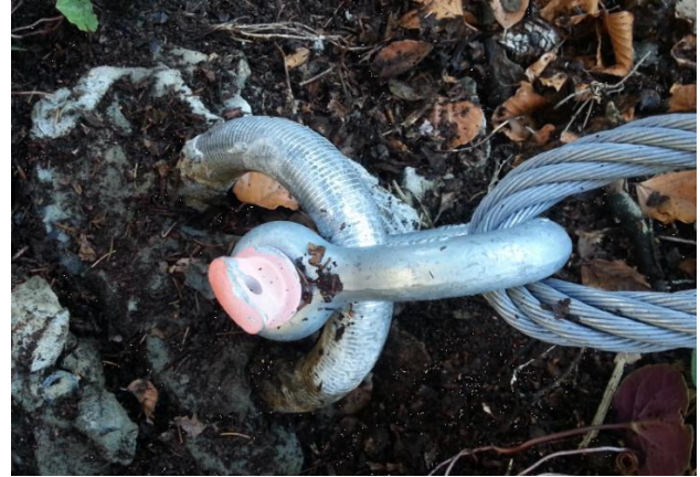
Abb. 14 Ankerkopf eines Ankers im Lockergestein.
