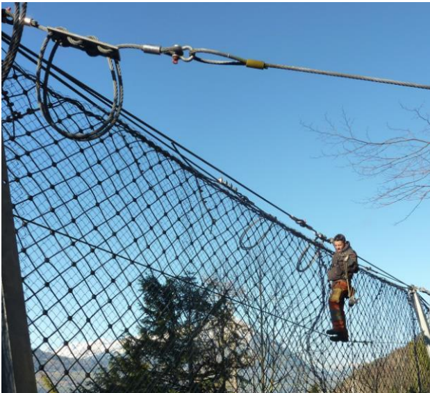
Abb. 6: Abschlussarbeiten. Sichtbar die Doppelparallel-Seilführung, Foto vom 20.3.2014.
