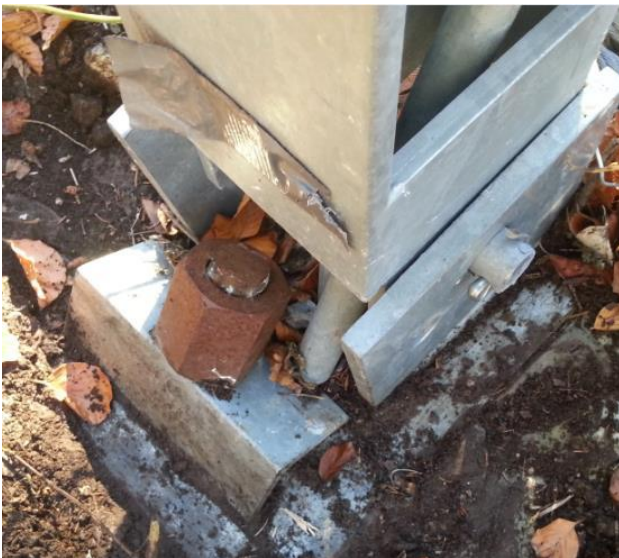
Abb. 15: Grundplatte einer Stütze mit dem Ankerkopf des Zugankers.
