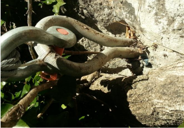
Abb. 13: Ankerkopf eines Felsankers.
