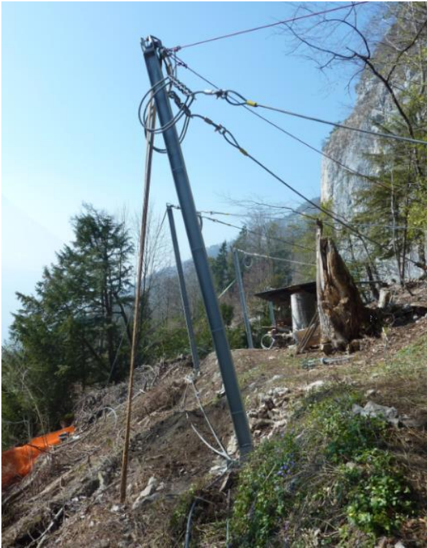
Abb. 5: Stützen mit provisorischen Rückhaltseilen vor der Netzmontage, Foto vom 12.03.2014.
