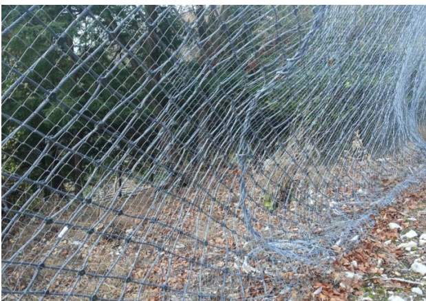
Abb. 11: Diagonaldrahtseilnetz mit und feinmaschigem Maschendrahtnetz. Gut sichtbar als Schlappnetz.
