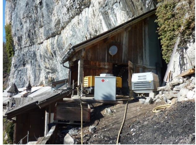
Abb. 6: Installation der notwendigen Maschinen nach Abschluss der Vorarbeiten (Felsreinigung, Säubern Baustelle, prov. Wege anlegen), Foto vom 20.2.2014.
