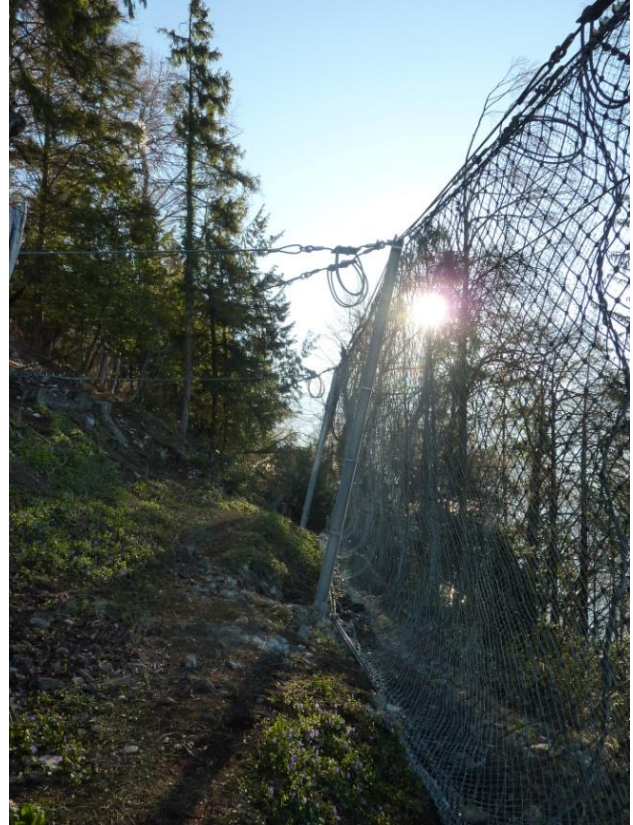
Abb. 10: Baustelle nach Abschluss der Aufräumarbeiten und Werkübernahme, Foto vom 2.4.2014
