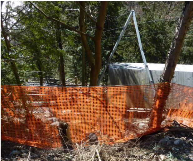
Abb. 7: Installierter Abrollschutz vor Beginn der Bauarbeiten, Foto vom 20.2.2014.
