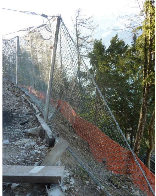
Abb. 7: Dreiecksnetz am westlichen Rand der Verbauung, Foto mit unbekanntem Datum. Sichtbar das Schlappnetz.
