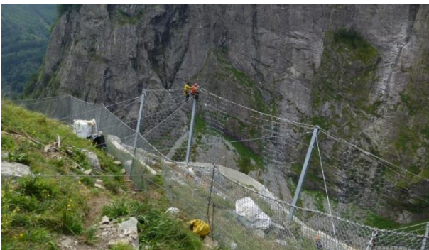
Abb. 6: Netz-Montage an der Werkreihe 4b. Im Vordergrund das S&P-Netz zur Baustellensicherung (Foto: Forsting AG).
