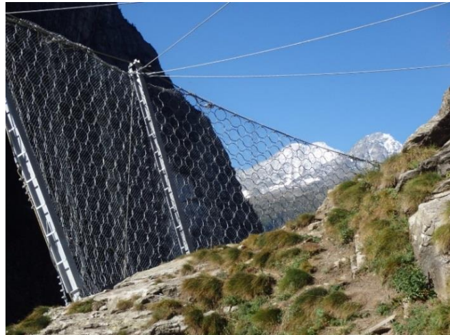
Abb. 1: Fertig installiertes Schutz-System RXI 100 der Geobruigg AG. Bild: S. Walther, ForstingPlus AG)
