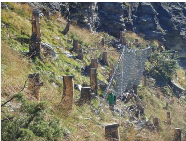
Abb. 8: Fertiggestellte Werkreihe 3. Hohe Stöcke sorgen für eine zusätzliche Rauigkeit der Sturzbahn und damit zusätzliche Energievernichtung (Foto: S. Walther).
