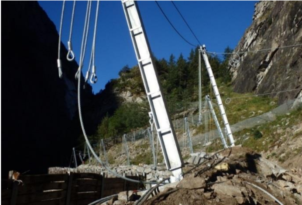
Abb. 4: Die Werkreihe 8b kurz vor der Montage der Netze. Diese Werkreihe wurde auf den Auffangdämmen errichtet Foto vom 25.09.2014 (S. Walther).
