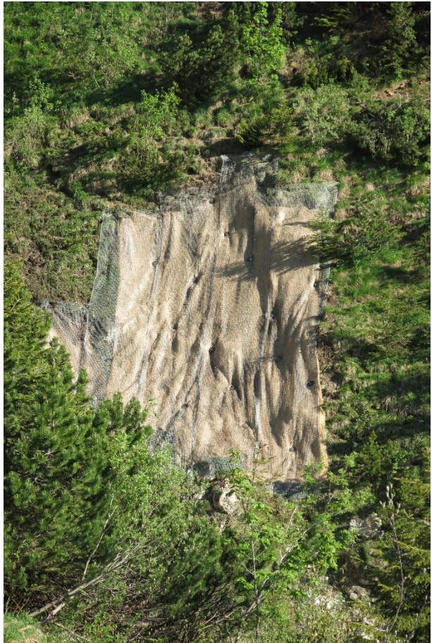
Abbildung 13: Details: Satte Geländeanpassung der Erosionsschutzvliese vom Gegenhang aus gesehen
