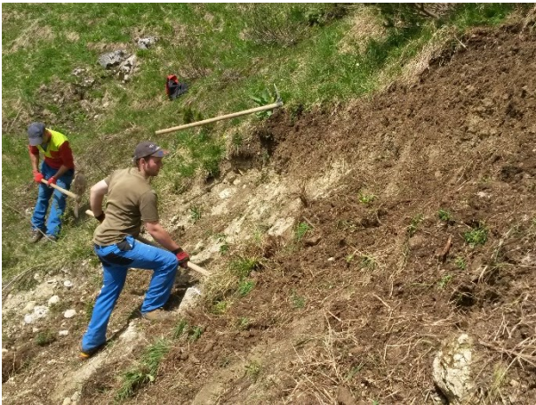
Abbildung 3: Vorbereitungsarbeiten: Brechen der Anrisskanten und Verteilen des Materials auf der Erosionsfläche.
