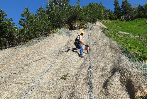
Abbildung 11: Neben der Rutschfläche ist ersichtlich, dass das Gelände mit Vegetationsbedeckung relativ stabil scheint.
