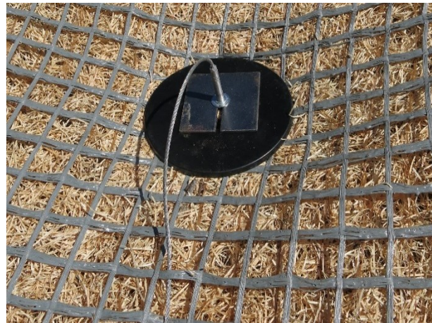
Abbildung 9: Detail: Die Presshülse des gespannten S&P-Ankers fixiert die S&P-Schlitzplatte und somit die Abdeckungen.
