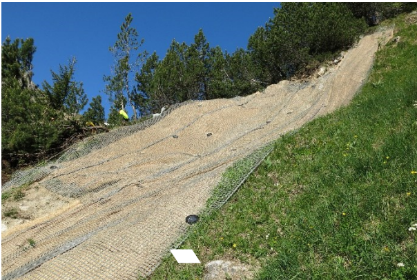
Abbildung 12: Oberhalb der Erosionsfläche erbringen die vorhandenen Bergföhren die nötige Bodenstabilisierung.
