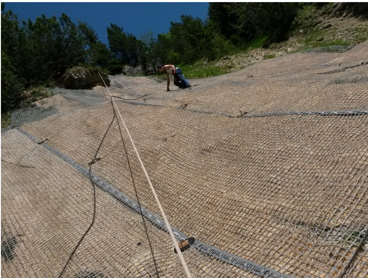
Abbildung 10: Die steile Hangneigung bedingt entsprechende Vorkehrungen für eine genügende Arbeitssicherheit: Durch die Arbeiten am hängenden Seil sind die Arbeiter gesichert und die Montage wird erleichtert.
