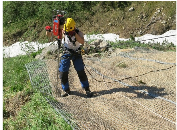
Abbildung 4: Nach Ausrollen der Erosionsschutzabdeckungen werden die S&P-Anker per Schlagbohrhammer eingetrieben.
