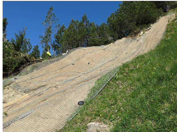
Erosionsschutzvlies mit Geotextilnetz und Erdanker fixiert
