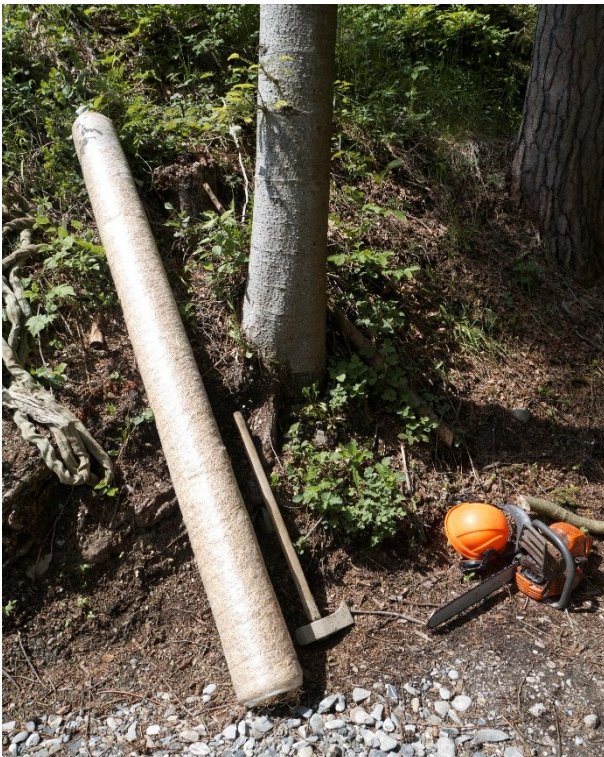
Abbildung 3: Erosionsschutzvliese sind durch geringes Gewicht gut handhabbar und einfach einzubauen (fobatec 2016)
