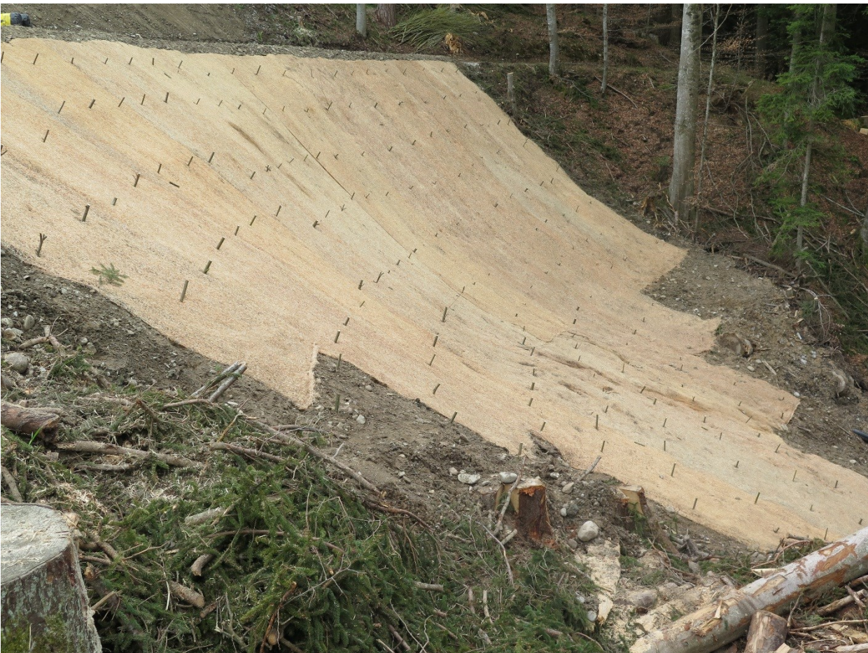
Abbildung 8: Die ausgelegten Erosionsschutzvliese überlappen jeweils seitlich und werden neben den Erdhaken durch Weidenstecklinge fixiert, welche langfristig den Hang durch das zunehmende Wurzelwachstum vor Erosion schützen sollen
