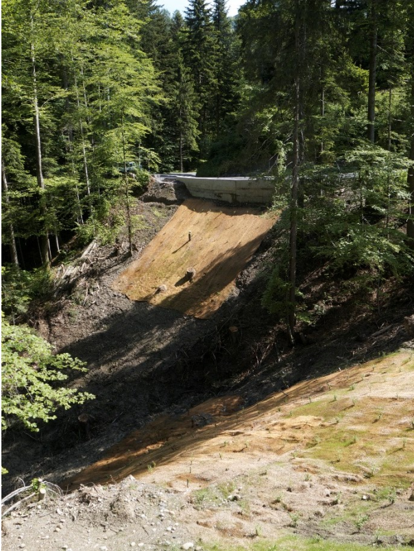
Abbildung 9: Gut einen Monat nach Einbau sind die Flächen sowie die Weidenstecklinge bereits z.T. ergrünt (fobatec 2016)
