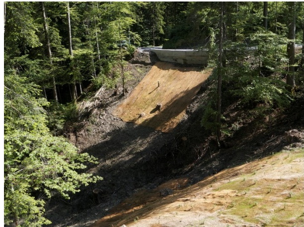
Erosionsschutzvliese schützen die talseitige Strassenböschung
