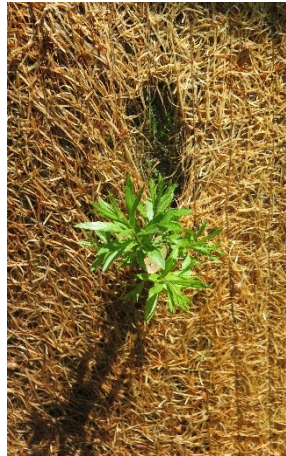
Abbildung 6/7: Die Weidenstecklinge haben sich gut etabliert; Detail links: eingerissenes Erosionsschutzvlies (ca. 15 cm)
