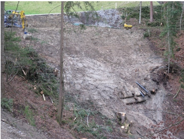
Abbildung 1: Die Hangfläche wurde zur Vorbereitung für den Einsatz der Erosionsschutzvliese mit dem Schreitbagger planiert
