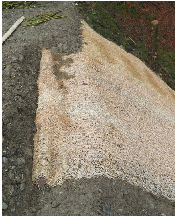
Abbildung 4: Der Endfalz des Erosionsschutzvlieses ist um eine Holzlatte gewunden und ins Bankett der Waldstrasse eingebaut
