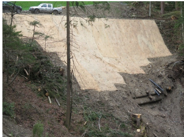
Abbildung 2: Die obere Hälfte der Rutschfläche ist mit Erosionsschutzvliese überdeckt und mit Weidenstecklingen bestückt
