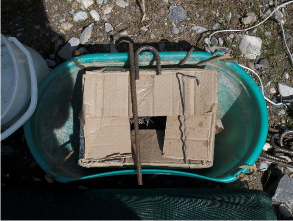
Abbildung 5: Im vorliegenden Projekt wurden die mitgelieferten Stahlhaften durch grössere J-Anker ersetzt (fobatec 2016)
