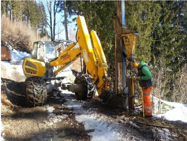
Abbildung 1: Maschinelles Eintreiben der Stahlprofile in den Boden unter Kontrolle der Positionierung per Wasserwaage
