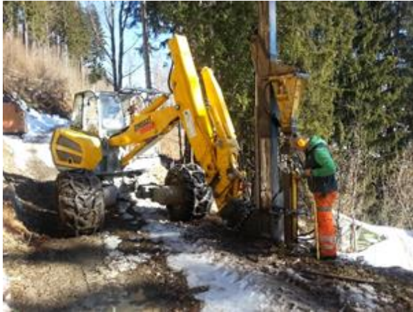
Illustration 4 : Enfonçage mécanique des poutres et contrôle de l'aplomb (niveau)
