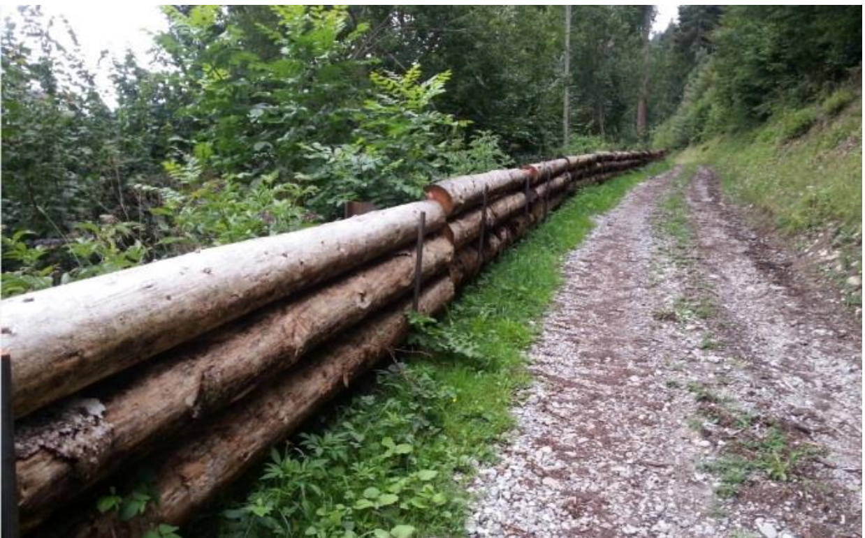
Abbildung 3: Fertiggestellte Rundholzhürden entlang der Erschliessung des Waldes „Le Dévin“, oberhalb der Ortschaft Cerniat (FR)
