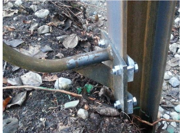
Abbildung 2: Verschrauben als alternative Befestigungsmöglichkeit neben dem Schweißen
