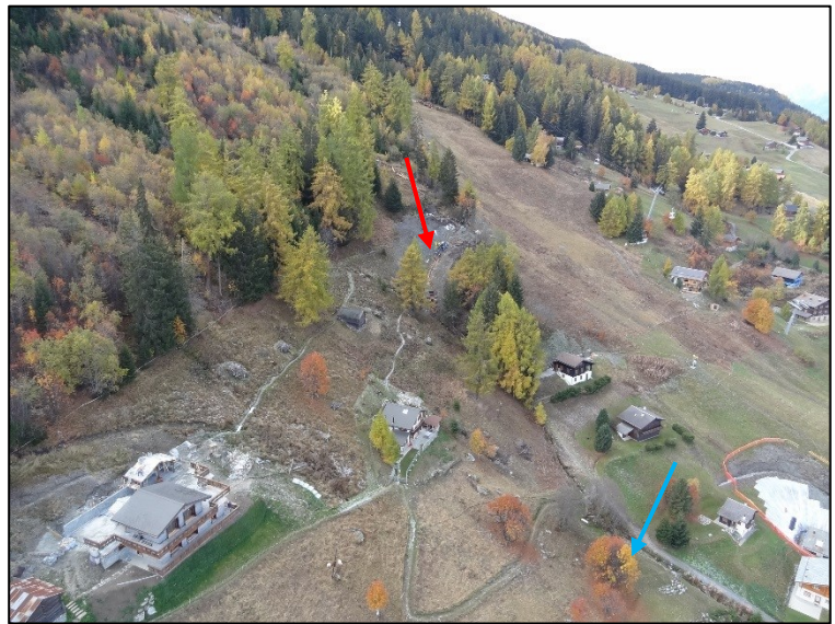
Photo 1 : Vue aérienne générale du site partie inférieure avec digue amont en construction (flèche rouge) et digue aval terminée (flèche bleue)
