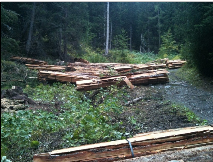
Photo 14 : Fagots de couenneaux répartis le long du futur drainage amont (1)
