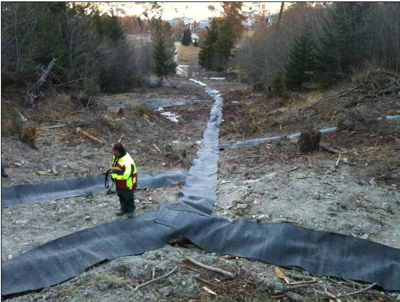
Photo 9 : Drainages en bois partie avale terminés, avec natte filtrante clouée par-dessus comme protection et pour maintenir l'humidité (6)
