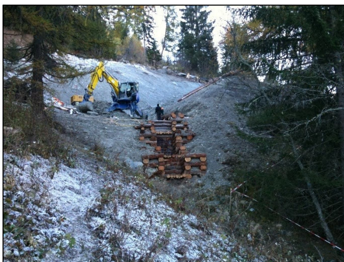
Photo 5 : Succession de 3 seuils pour briser l'énergie des écoulements et assurer la sortie de la digue "Les Clèves amont" (arrivée dans le torrent de Tsabloplan) (7)
