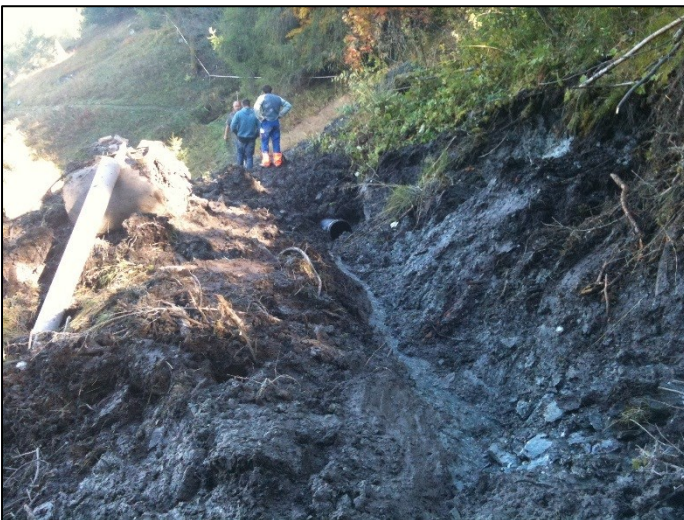
Photo 4 : Captage des eaux provenant des drainages en bois (aménagement provisoire avant la mise en place de la bâche étanche, du tuyau perforé et du Misapor) (7)
