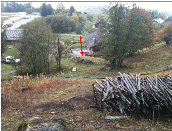
Photo 2 : Digue de déviation "Les Clèves aval" (8)
