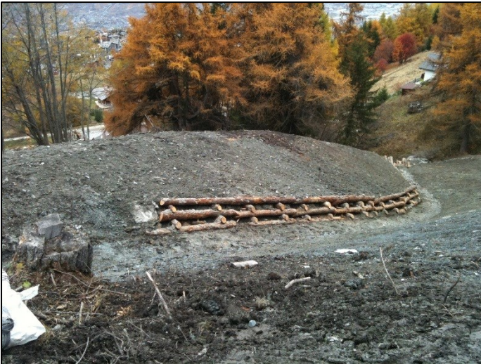
Photo 3 : Digue de déviation "Les Clèves amont" (7)
