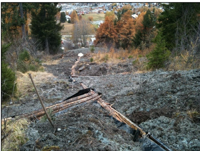
Photo 8 : Drainages en bois en cours de construction; la découpe des ligatures n'a pas encore été faite. (6)
