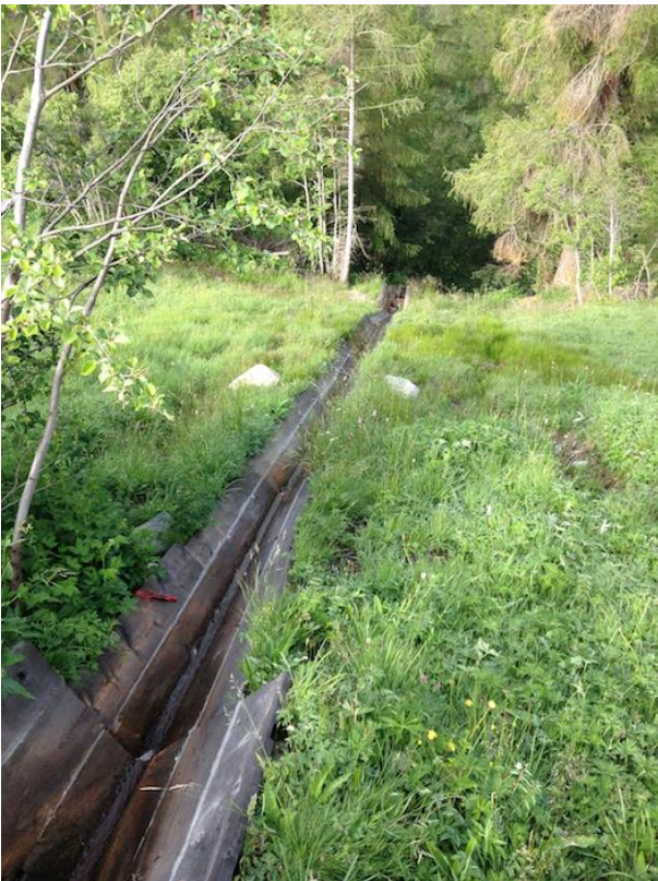
Abb. 8: V-Kanäle 2 Jahre nach Abschluss des Baus.
