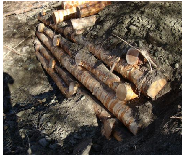
Abb. 7: Holzkasten während der Bauphase.
