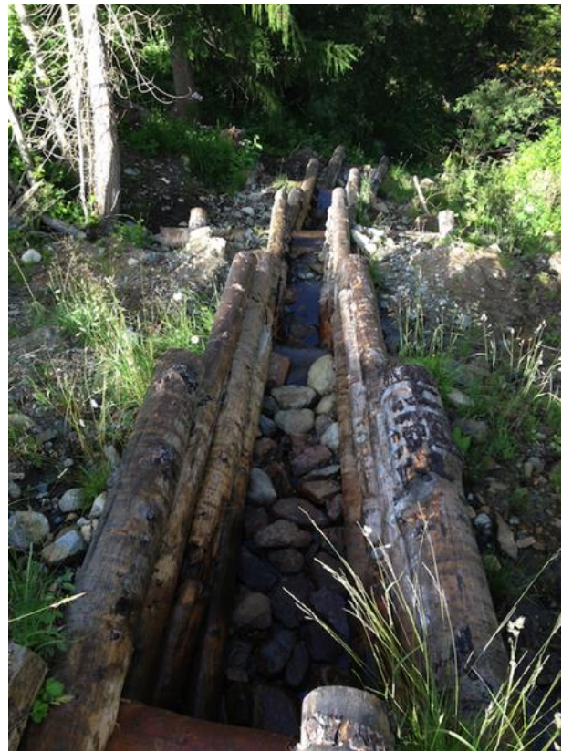
Abb. 9: Fertiggestellte Holzkästen mit Steinkolkschutz.
