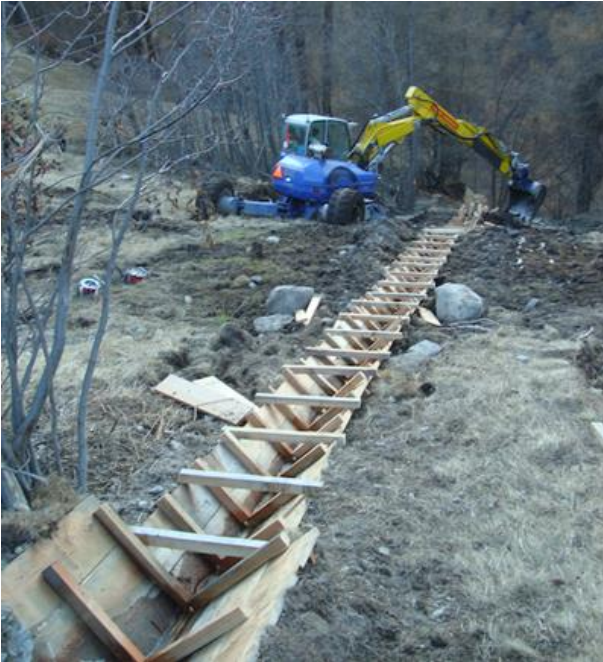
Abb. 6: Erste Version der V-Kanäle in der Bauphase
