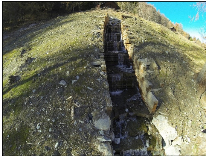
Photo 1 : Vue générale de l'ouvrage terminé
