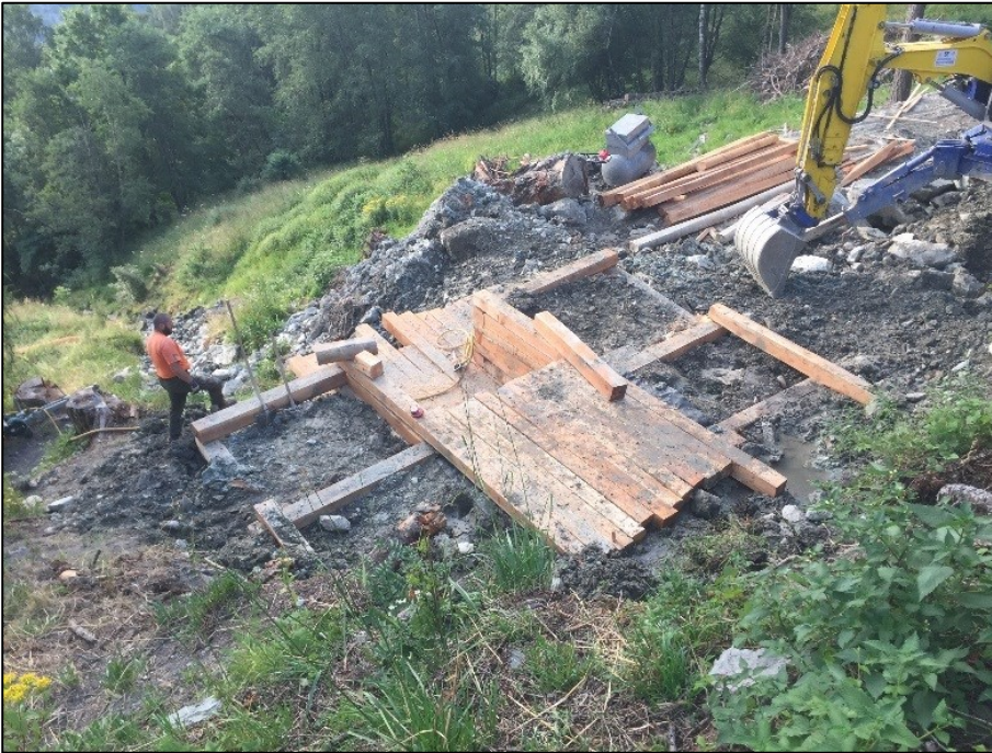
Photo 4 : Début de la construction de l'ouvrage
