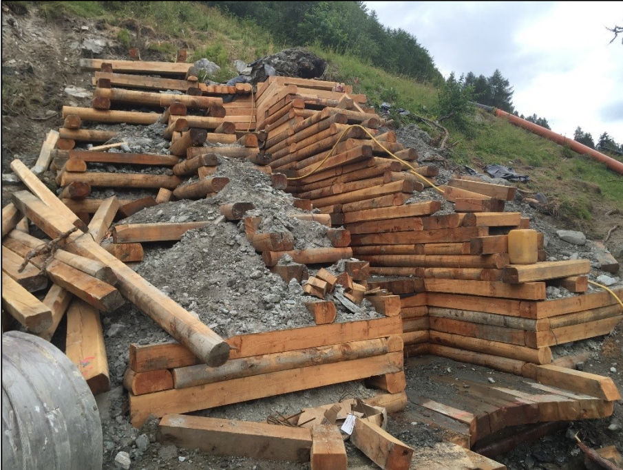
Photo 6 : Ouvrage en cours de construction
