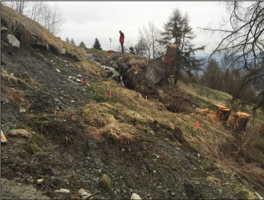
Photo 2 : Vue de la niche d'arrachement du glissement et de l'implantation de l'ouvrage (partie sommitale)
