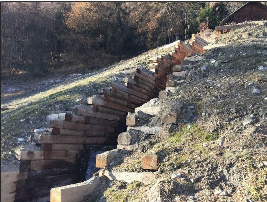
Photo 7 : Torrent remis en eau, berges remblayées etensemencées
