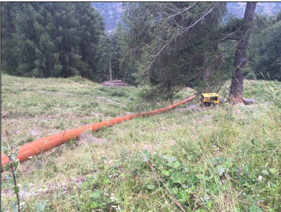
Photo 3 : Déviation provisoire des eaux du torrent à l'aide d'un tuyau d'un diamètre de 40 cm
