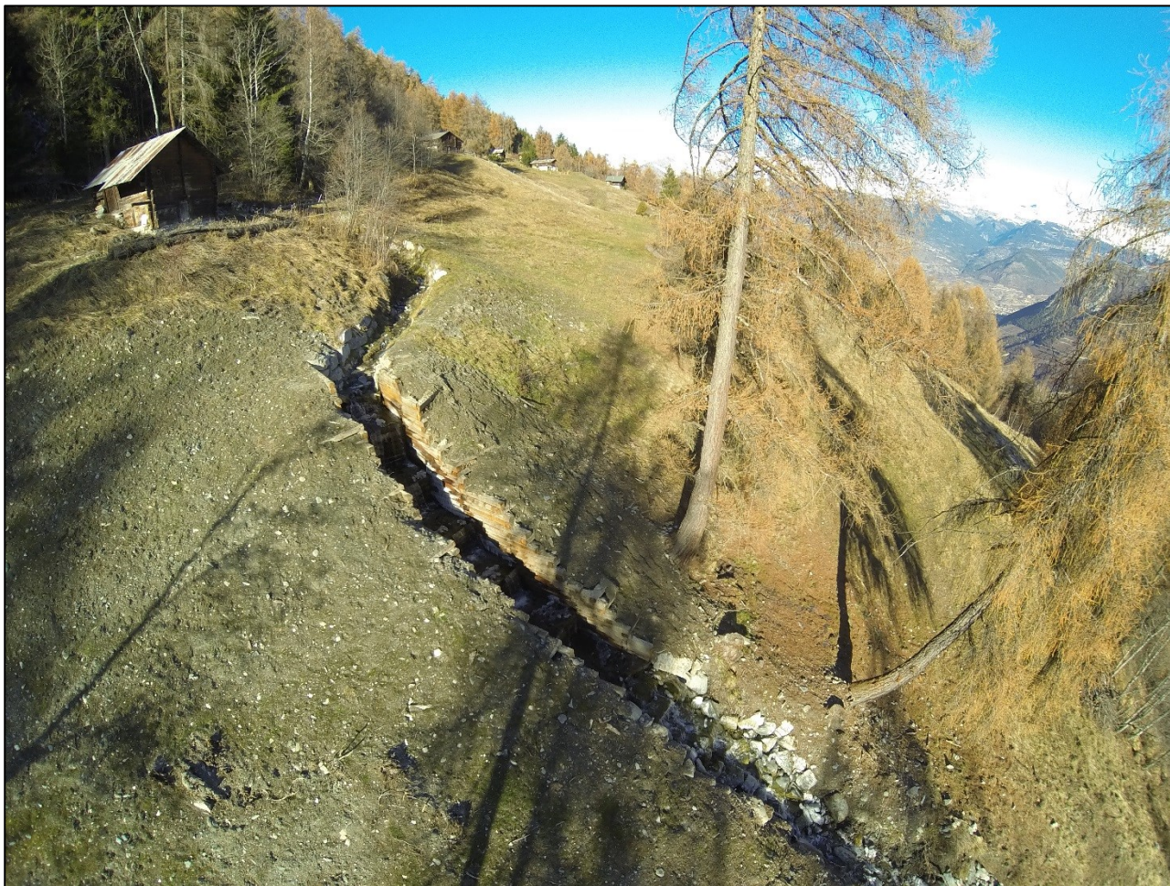
Photo 7 : Vue générale de l'ouvrage terminé
