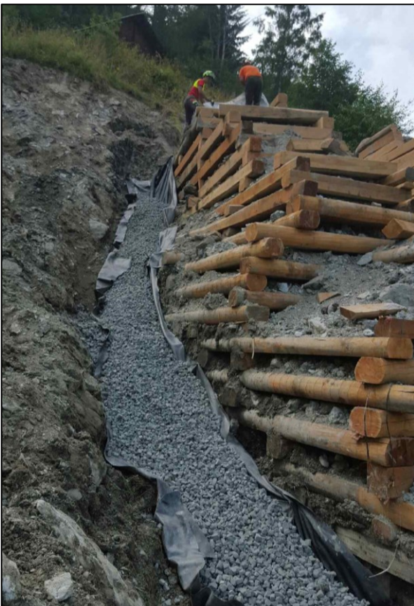
Photo 5 : Pose du drainage à l'extérieur de l'ouvrage; le corps drainant est constitué de verre expansé (Misapor), beaucoup plus léger que des graviers, ceci afin d'optimiser les coûts de transport par hélicoptère.
