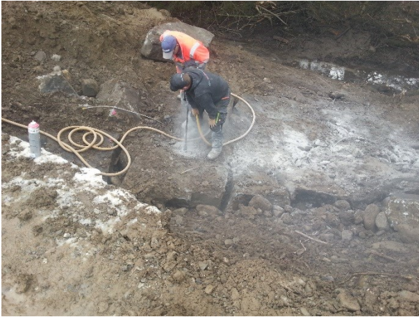
Abbildung 1: Bohrarbeiten für die Versetzung der Stabanker
