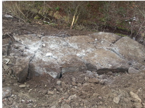
Fertiggestellte Lage der sich im Bau befindenden Blocksteinbuhne
