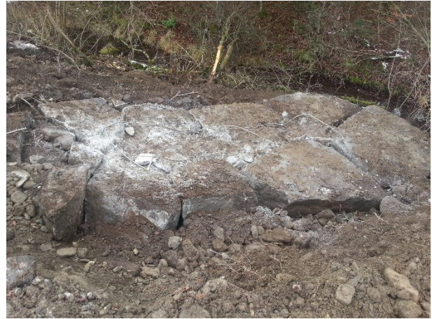
Abbildung 2: Erste fertiggestellte Blocksteinschicht mit versetzten Anker und fixierten Stahlseilen
