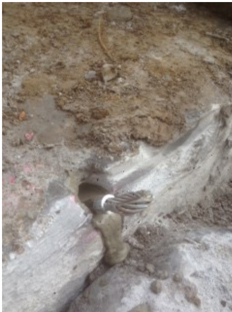
Abbildung 3: Detail: Schlaufe, an welcher das Stahlseil befestigt wird
