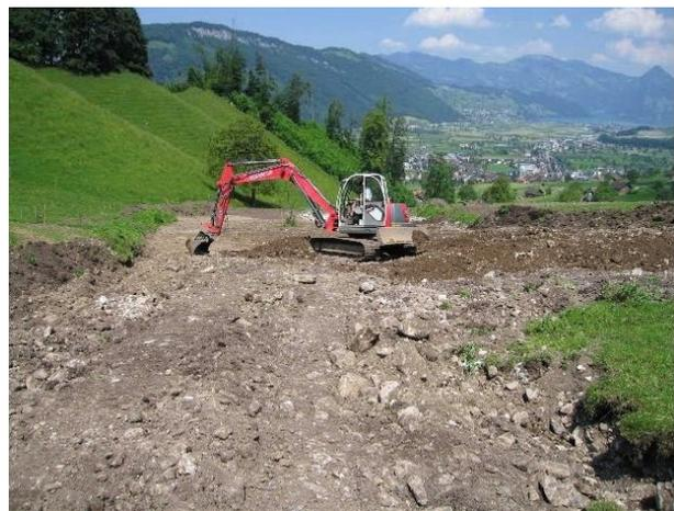
Abbildung 4: Anpassung des Geländes von der Baupiste aus
