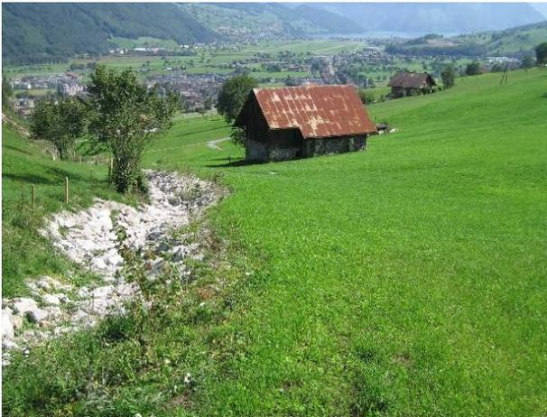
Abbildung 7: Raubettrinne mit erhaltener und z.T. neu gepflanzter Uferbestockung (Niederhecke, u.a. mit Weidenarten)
