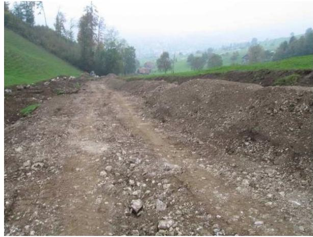
Abbildung 2: Erstellte Baupiste neben der zu bauenden Raubetrinne, das Abtragsmaterial wurde wallförmig deponiert
