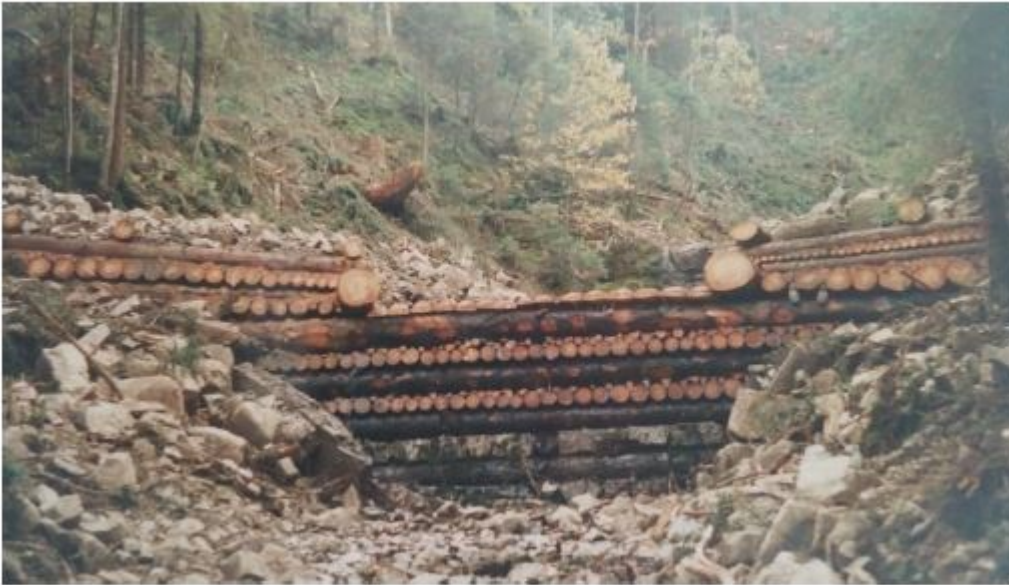
Photo 4 : rénovation du seuil (partie supérieure) sur la base en bois et pierre d'origine (cas 2)
