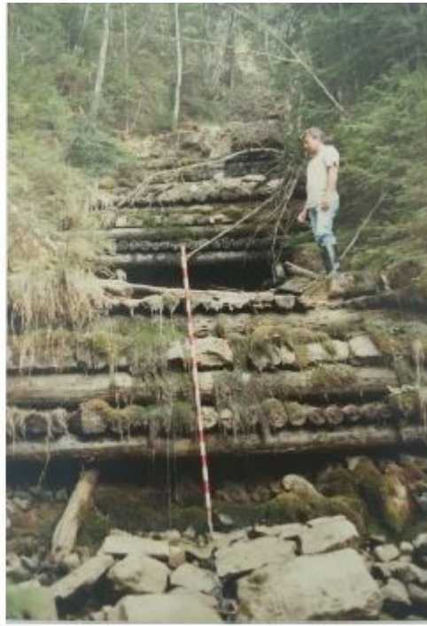
Photo10 et 11 : Etat des seuils avant rénovation et dégâts dus à l'affouillement
