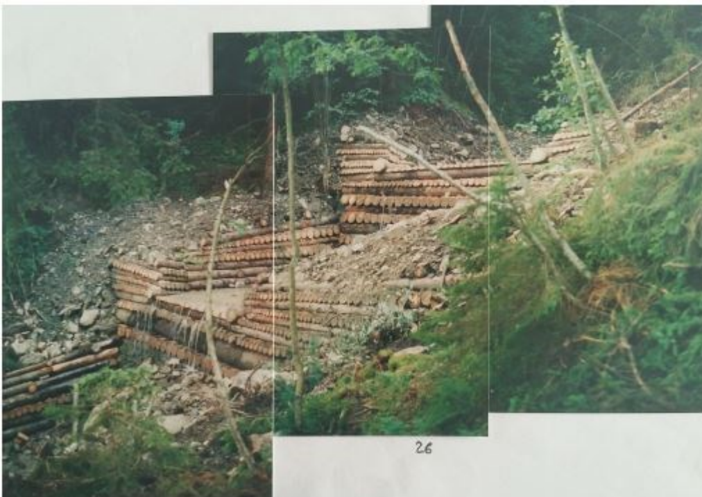
Photo 5 : seuils 26 et 27 : soutènement de la rive droite contre l'érosion en aval du seuil 27 et 26 (affluent en rive gauche, au-dessus du seuil 27)
