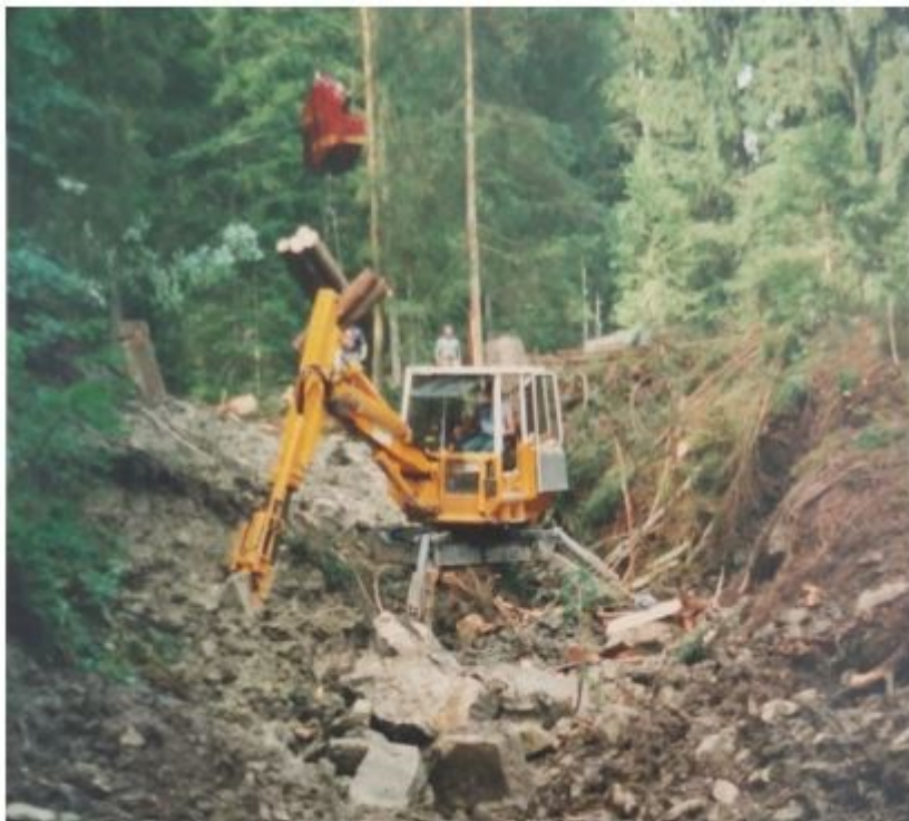
Photo 7 : préparation d'une protection des berges avec des pierres d'un ancien ouvrage
