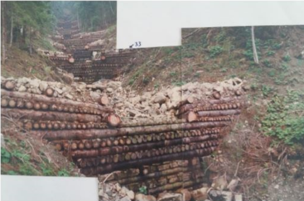
Photo 8 : seuil 32 et suivants
