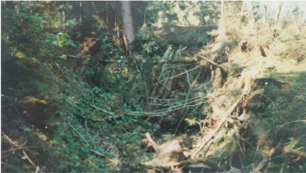
Photo 6 : affluent en amont du seuil 27 après abattage et préparation du chantier
