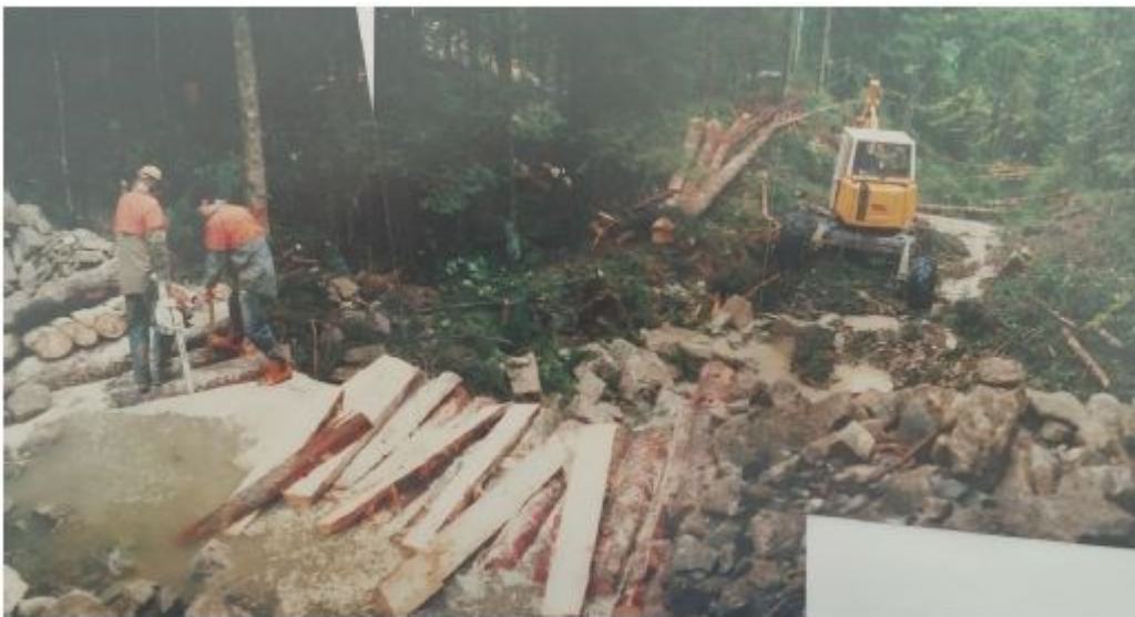
Photo 1 : Rénovation de l'aile d'un et remise en état du lit du torrent
