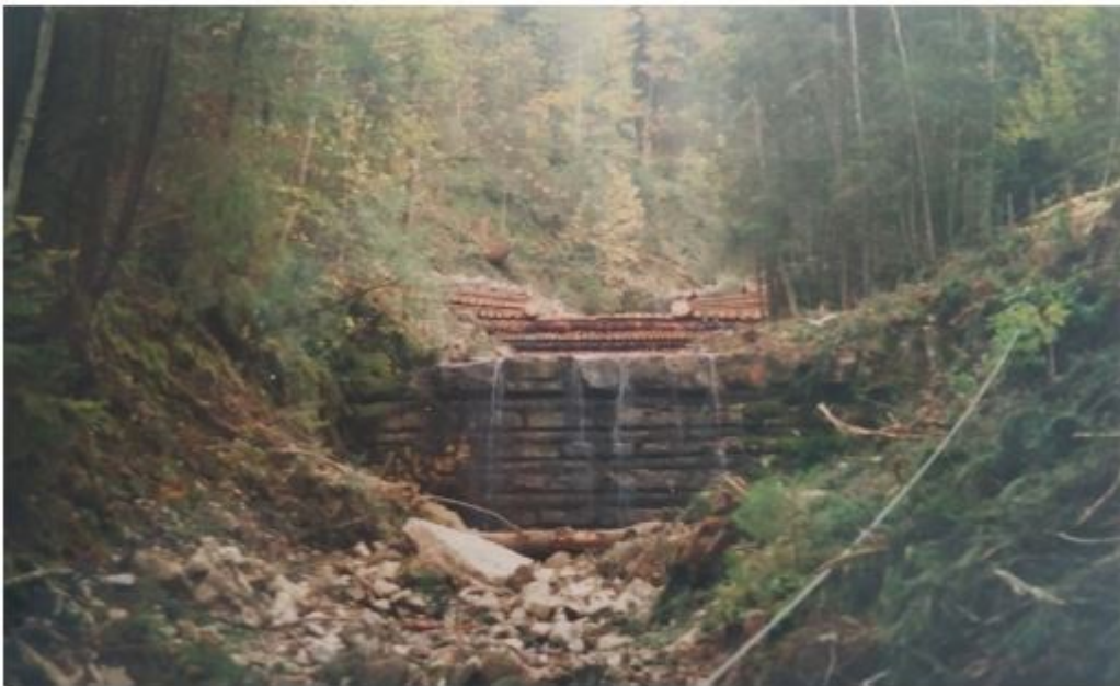
Photo 3 : seuil 5 original et seuil 6 rénové
