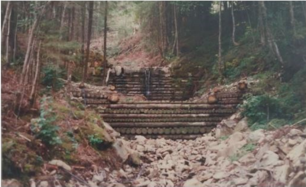
Photo 2 : seuil 4 : nouvel ouvrage (cas 1) . Derrière : ancien ouvrage en bon état
