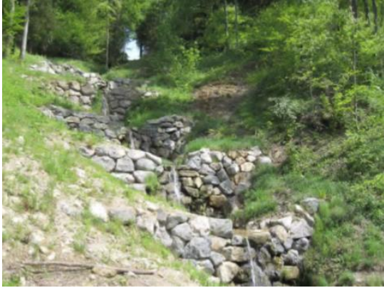
Abbildung 10: Blocksteinsperren nach Erstellung (Quelle: belop gmbh, 12.05.2015)
