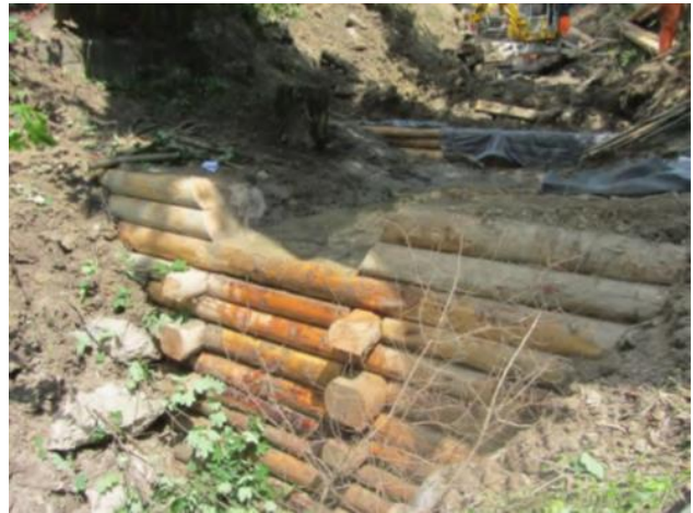
Neue, einwandige Holzsperrern im Silberbach, Stallikon ZH
