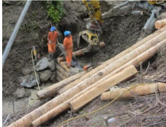
Abbildung 5 Bau einwandige Holzsperr Nr. 4 mit gesägtem Lärchenrundholz (Quelle: belop gmbh, 25.06.2014)
