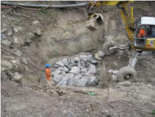
Abbildung 6 Bau Blockstufe Nr. 9 in Fels (Quelle: bleop gmbh, 28.05.2014)
