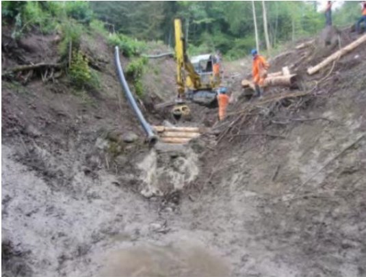
Abbildung 4 Bau einwandige Holzsperr Nr. 4 (Quelle: belop gmbh, 25.06.2014)
