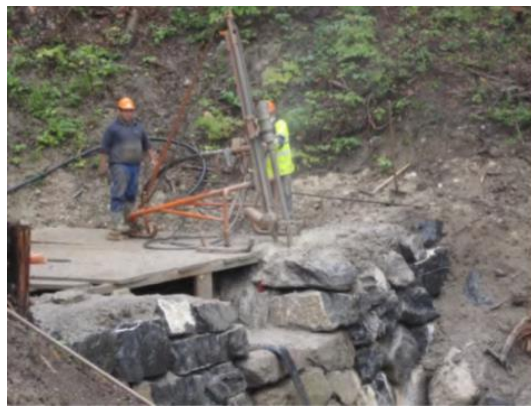
Abbildung 9 Nachinjektionen bei 3 Blocksteinsperren mit zu trocken eingebauten Beton (Quelle: belop gmbh, 02.07.2014)
