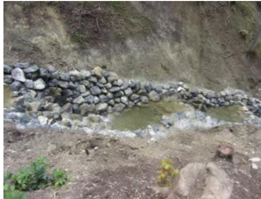
Abbildung 7: Stufen-Becken-System Nr. 9 nach Erstellung (Quelle: belop gmbh, 23.07.2014)
