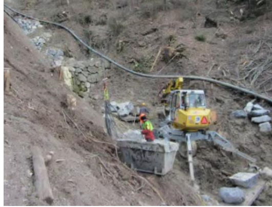
Abbildung 11: Erstellung Blocksteinsperre (Quelle: belop gmbh, 19.03.2014)
