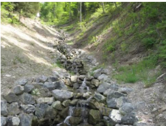
Abbildung 8: Stufen-Becken-System nach Erstellung (Quelle: belop gmbh, 12.05.2015)
