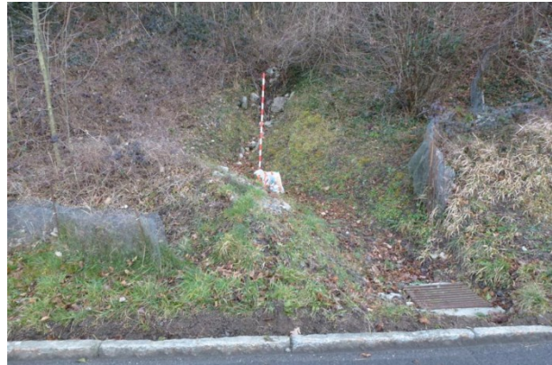
Abbildung 2: Absteckung für Geschiebesammler am Graben 1
