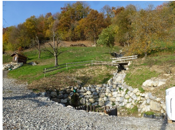
Geschiebesammler am Graben 3 mit Einlaufbauwerk
