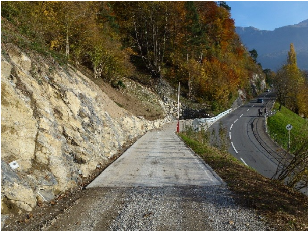
Abbildung 9: Einfahrt zur Erschliessung der Geschiebesammler, die Barriere soll unerlaubtes Befahren verhindern und der Betonüberzug ein übermässiges Verschmutzen der Kantonsstrasse und eine Erosion der steilen Rampe zu Beginn der neuen Erschliessung
