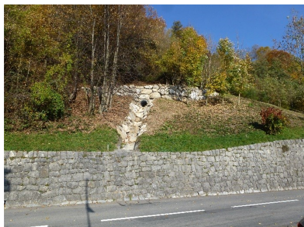
Abbildung 6: Auslaufdurchlass beim Geschiebesammler 4 mit anschliessendem Unterlaufbauwerk in Form einer Raubetrinne
