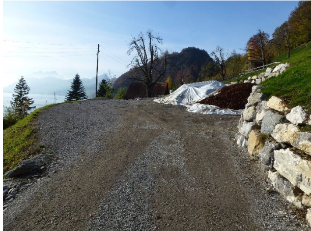
Abbildung 10: Der Kehrplatz wurde erstellt, um eine effiziente Räumung der Geschiebesammler per LKW zu ermöglichen
