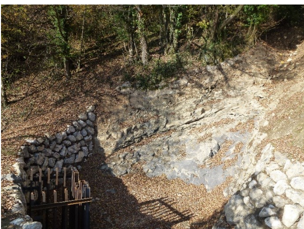
Abbildung 5: Rückhalteraum des Geschiebesammlers beim Graben 4
