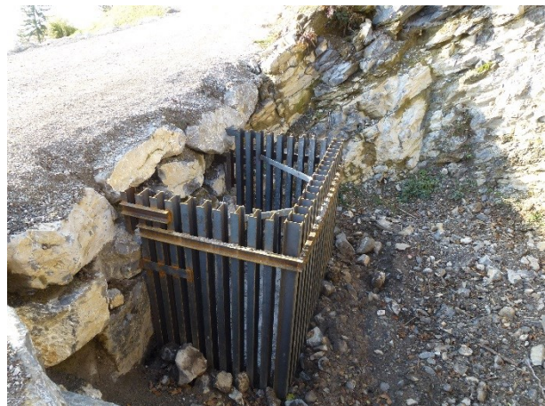
Abbildung 4: Detail Geschieberechen 2
