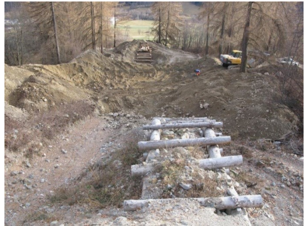
Abbildung 2: Pendenter Zusammenschluss der untersten zwei Dammetappen und Materialdeponie 2015
