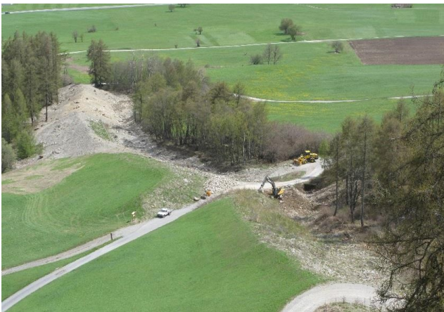
Abbildung 7: Blick auf die fertig erstellten Dämme im April 2016.
