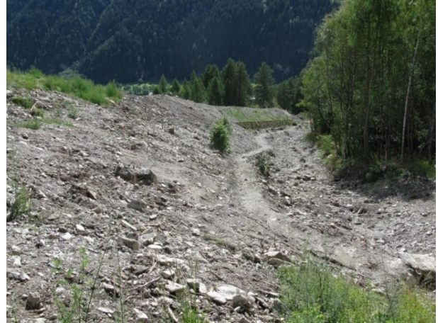
Abbildung 6: Rekultivierung der bachseitigen Böschung und Instandstellung alter Fusswegverbindung (oberer Damm)
