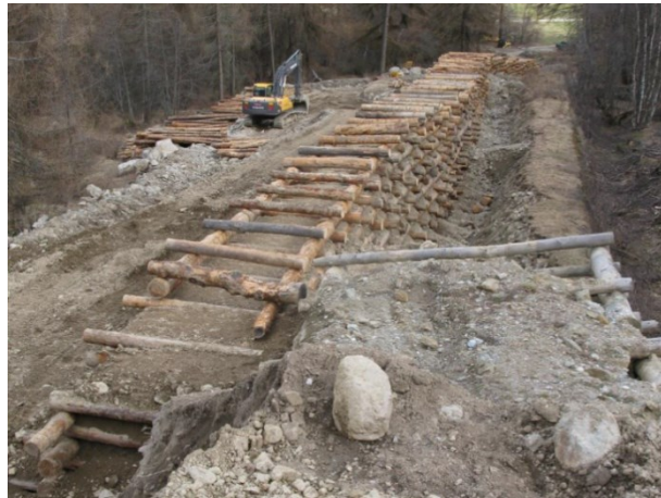
Teilweise verfüllter Holzkasten des Schutzdammes
