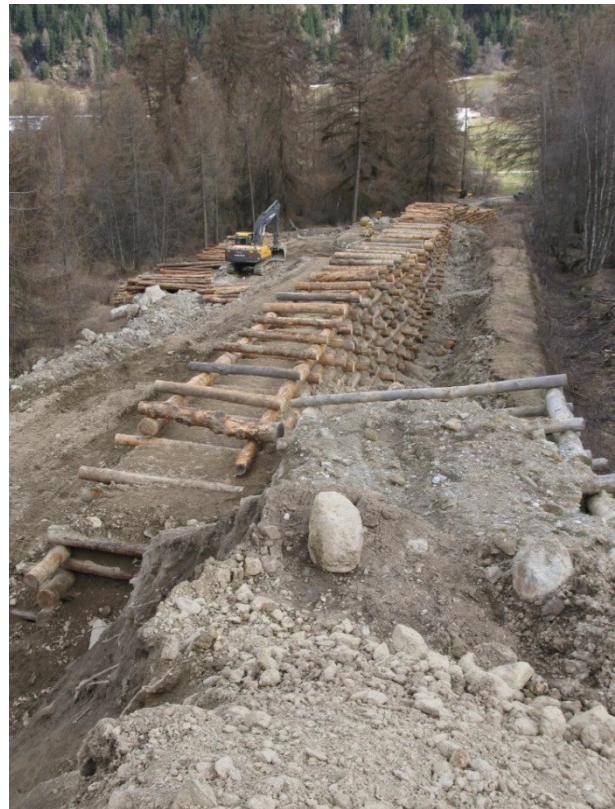
Abbildung 4: Anschluss mittlere und obere Etappe des unteren Dammes; Erhaltung alter Bruchsteinmauer als Erosionsschutz
