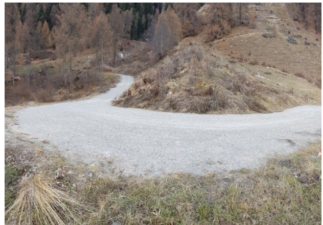
Abbildung 8: umgelegte Erschliessung über den neuen Damm im November 2016.
