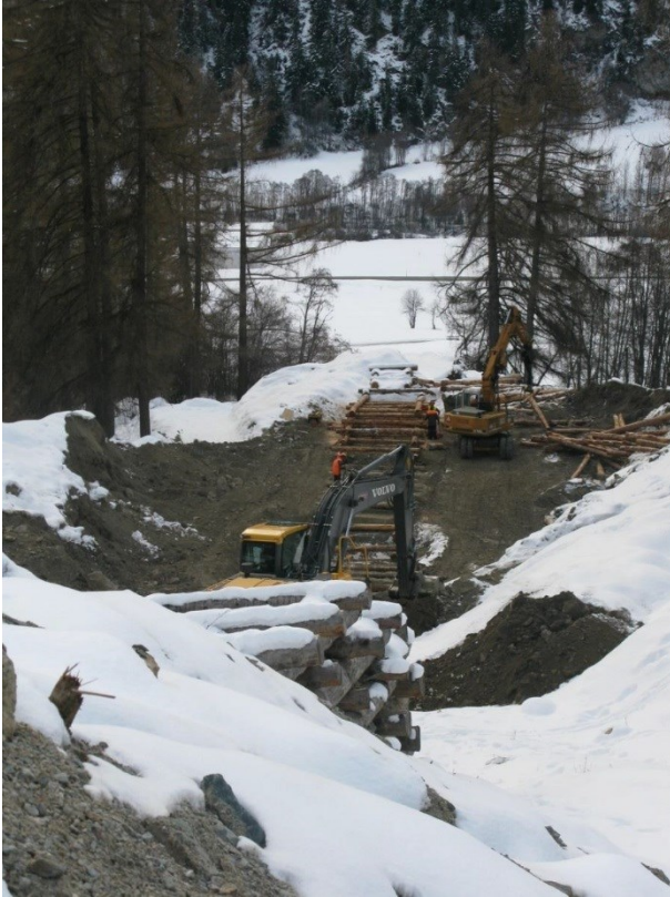
Abbildung 5: Start der Baumassnahmen anfangs 2016; Zusammenschluss der zwei unteren Etappen des unteren Damms (Überlappung der Holzkasten)
