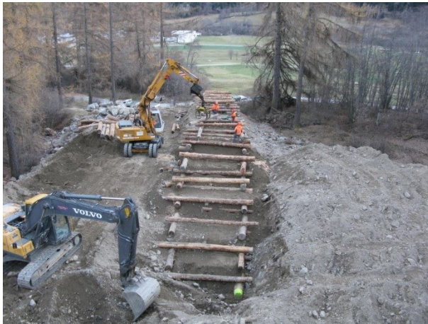
Abbildung 1: Holzkastenbau und laufende Verfüllung mit Erdmaterial (Forstwartlehrlinge im Baukurs Sommer 2015)
