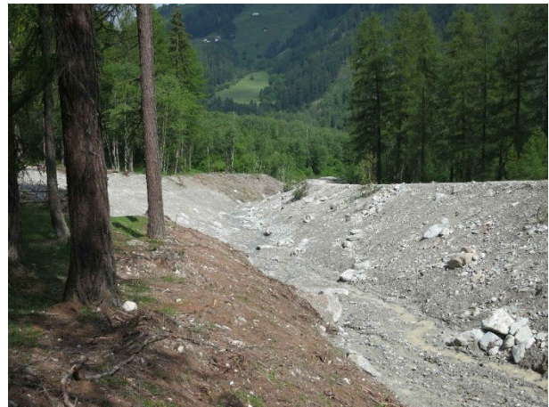
Abbildung 10: Die naturnahe, strukturreiche Gerinnegestaltung bietet einen möglichst natur- und landschaftsverträglichen Bau
