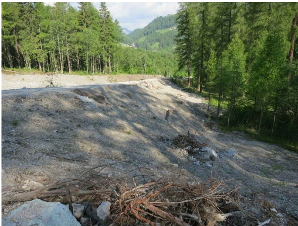
Abbildung 9: Luftseitige, bachabgewandte Böschung mit natürlicher Böschungsgestaltung zur Landschaftseingliederung
