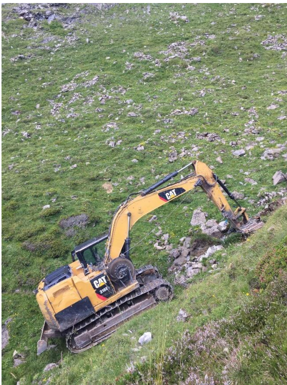
Abbildung 16: Verlegen der Wasserleitung mittels des Anbau-Grabenpflugs. Gut sichtbar ist die auf dem Bagger montierte Hilfswinde.
