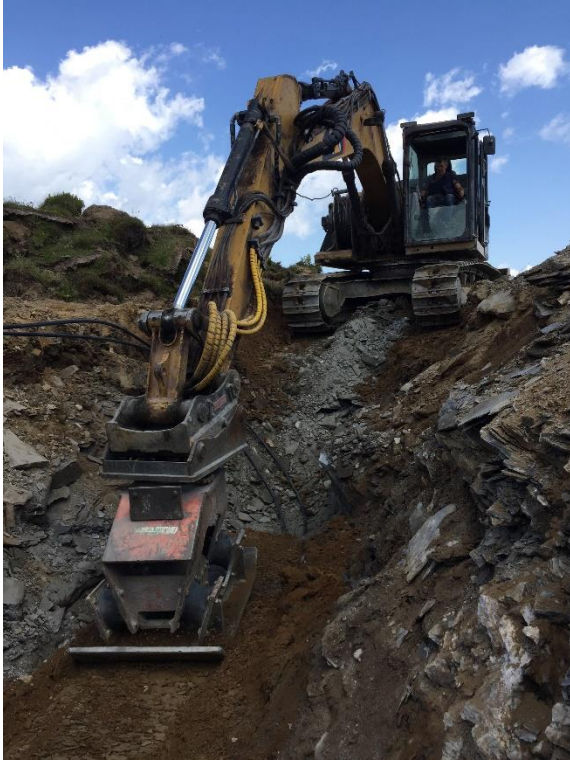
Abbildung 10: Verdichten des geschlossenen Leitungsschlitz mittels Anbauverdichter
