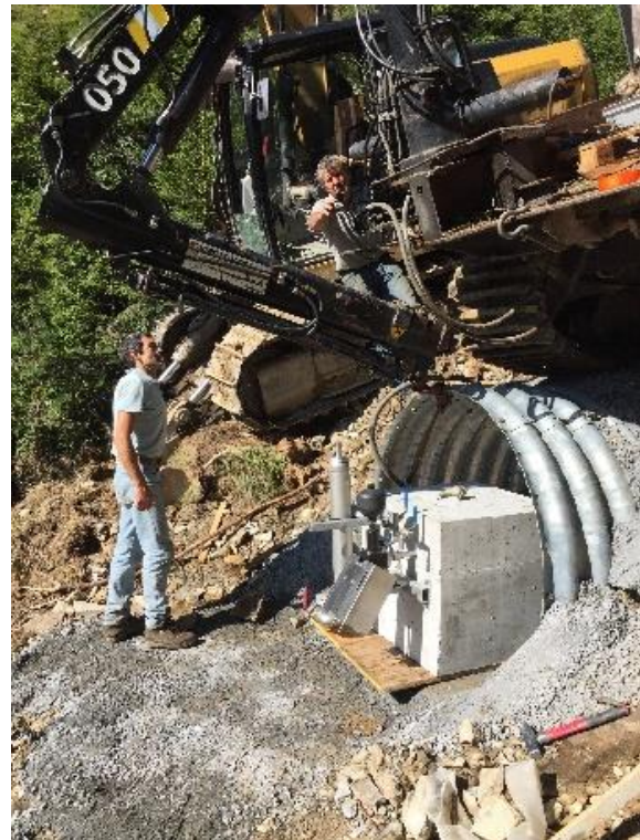
Abbildung 9: Montage / Positionierung des Widders in den eigens angefertigten Unterstand
