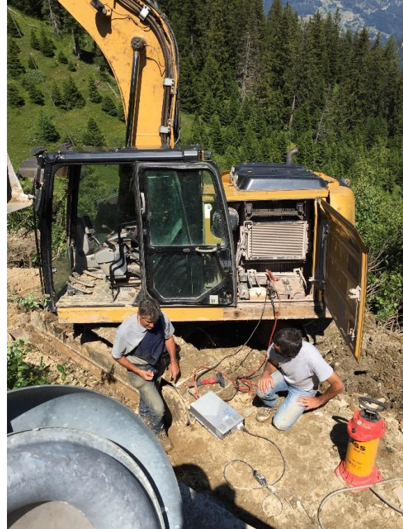
Abbildung 11: Strom für die elektrischen Geräte auf der Baustelle wird direkt von der Batterie des Baggers mittels Wechselrichter gewonnen.
