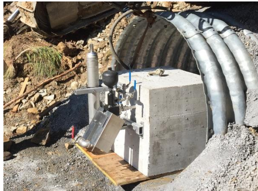
Abbildung 1: Einbau der Widderpumpe
