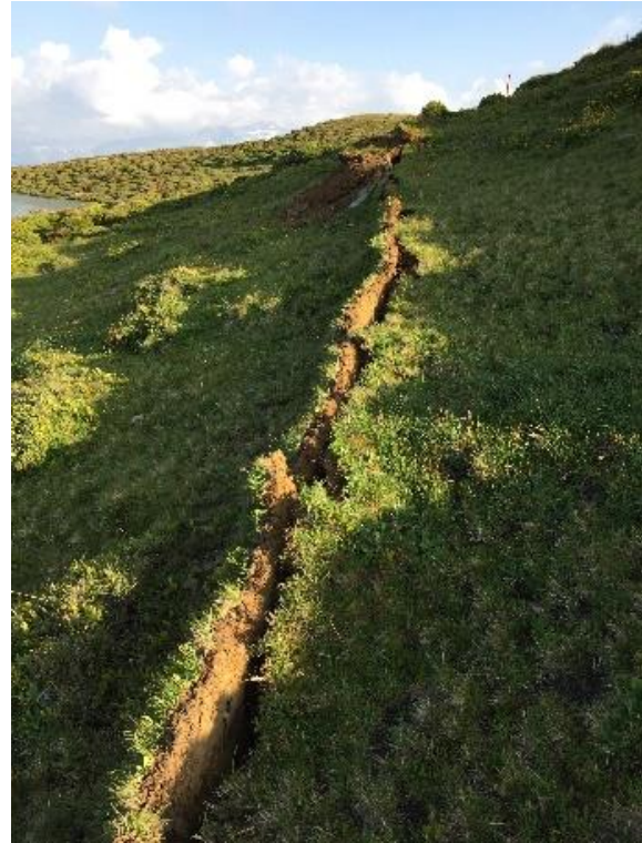
Abbildung 7: Nur ein kleiner Schlitz nach dem Verlegen der Leitung ist sichtbar.
