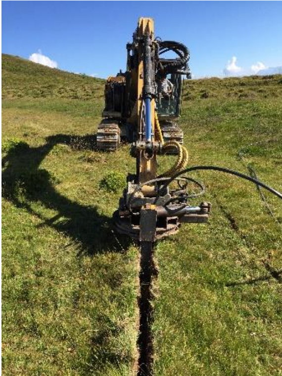
Abbildung 6: Verlegen der Wasserleitung mit dem Anbau-Grabenflug am Bagger.
