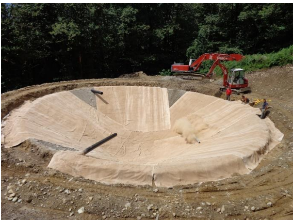
Verlegen von Bentonitmatten Posa delle stuoie bentonitiche Pose des tapis de bentonite
