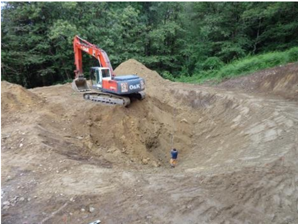
Aushub Löschwasserteich Scavo della vasca Excavation du bassin
