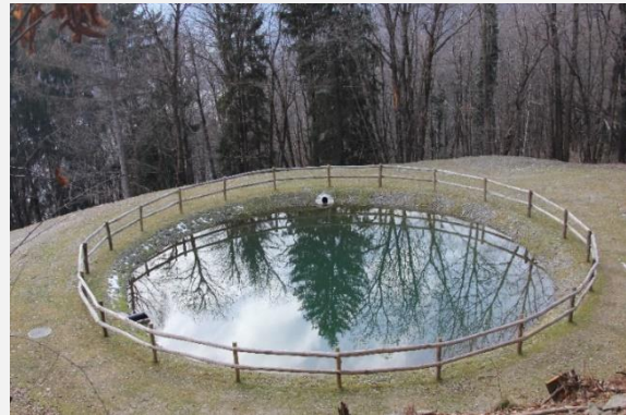
Fig. 1 Vasca antincendio San Vittore (fonte: AWN GR)
