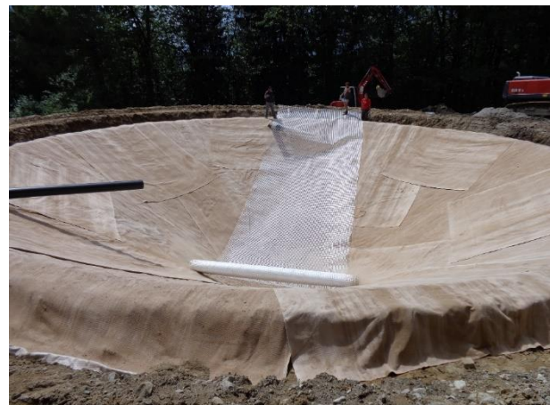
Abdecken der Bentonitmatten mit Geogitter Posa della geogriglia Recouvrir les tapis de bentonite avec géogrilles
