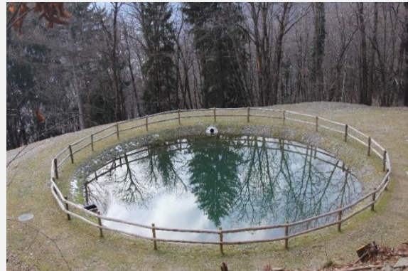
Abb. 1 Fertiggestellter Löschwasserteich (Quelle: AWN GR)
