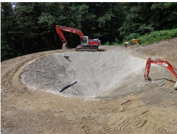
Überdecken der Geogitter mit Gesteinsmischung Copertura delle stuoie bentonitiche Recouvrir les géogrilles de matériaux meubles
