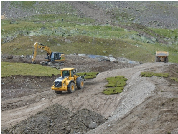
Abbildung 3: Transport der Rasenziegel mit Pneuader
