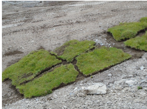
Abbildung 4: Abgetragene Rasenziegel bereit für den Einbau
