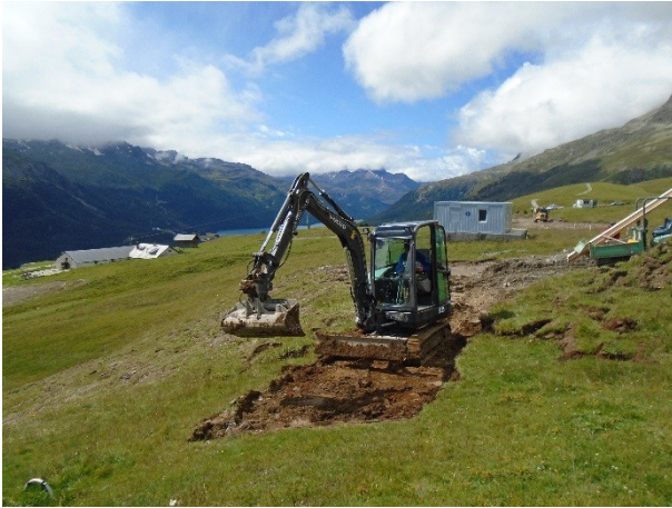
Abbildung 1: Abtrag von Rasenziegeln zur Erstellung der Baustellenzufahrt
