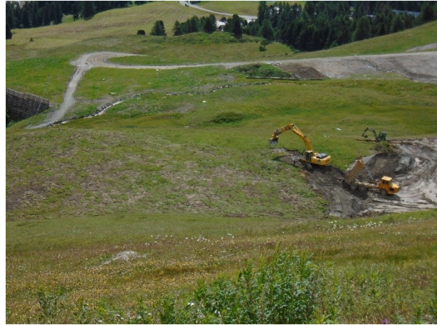
Abbildung 2: Schüttung und Direktumlagerung von Rasenziegeln
