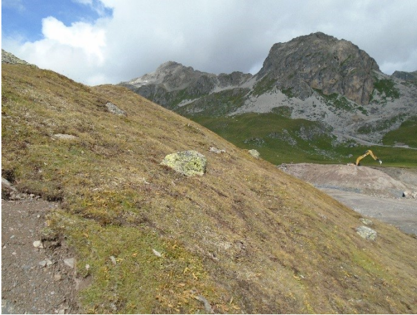
Abbildung 7: Direktumgelagerte Böschung inkl. versetzter Steinblöcke
