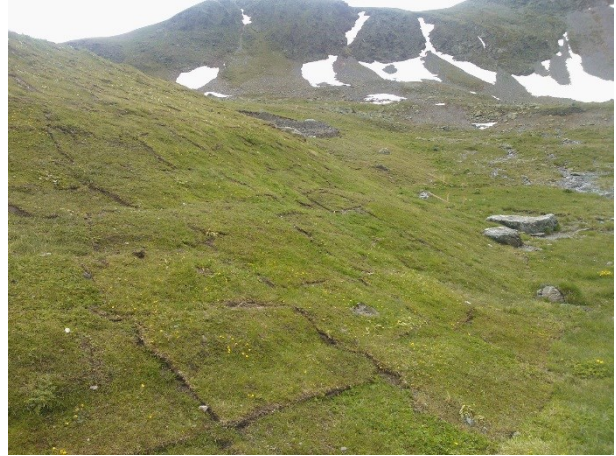
Abbildung 8: Frisch verlegte Rasenziegel
