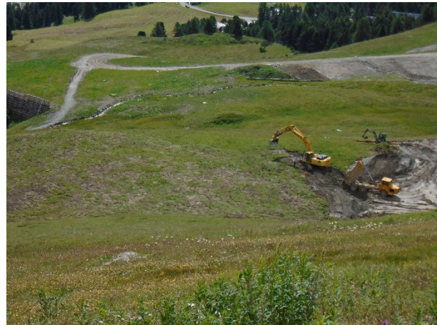
Schüttung mit Direktumlagerung des Oberbodens
