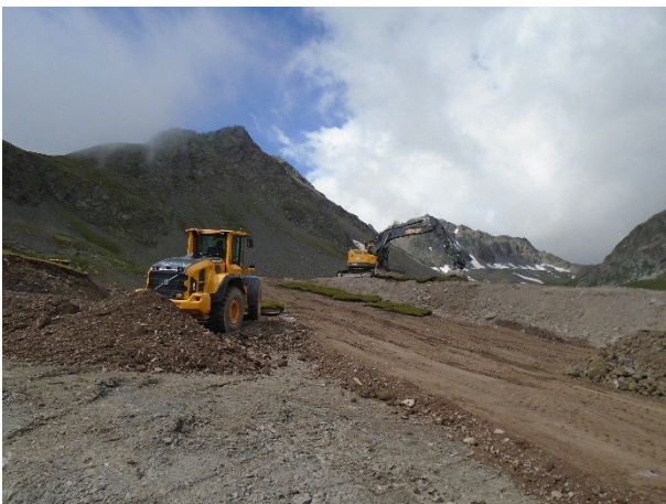
Abbildung 5: Maschinelles Versetzen der Rasenziegel
