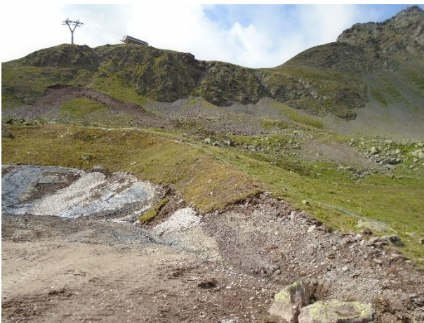
Abbildung 9: Neu angelegte Böschung
