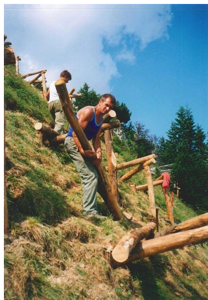
Abbildung 6: Bereitstellung der Trägerhölzer
