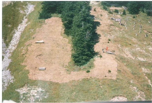
Abbildung 4: Kastanienholz nach Helitransport verteilt auf der Verbaupläche
