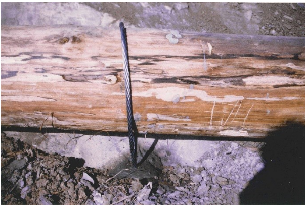
Abbildung 13: Detail Schwellenverankerung mit vermörteltem Stahlseil
