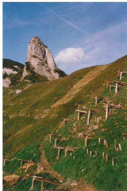
Abbildung 16: Begehungsweg im Verbaubgebiet
