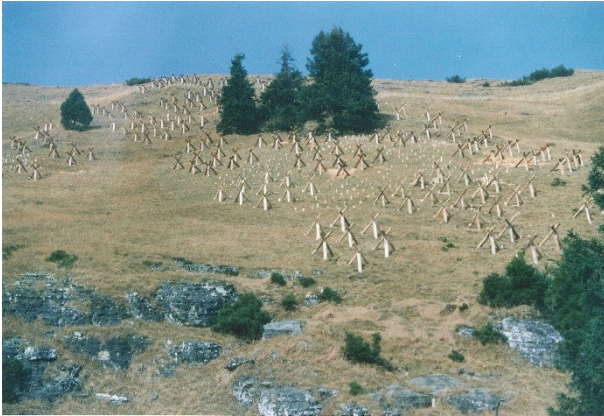
Abbildung 1: Dreibeinböcke ergänzt mit Pfählungen
