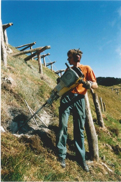
Abbildung 11: Bohrarbeiten für Schwellenverankerung
