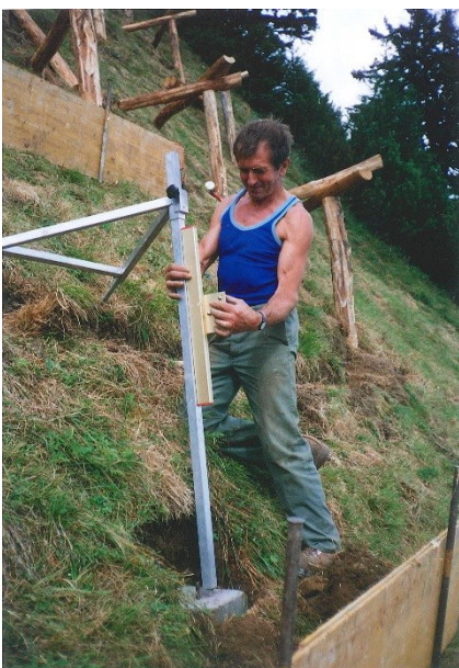
Abbildung 5: Festlegen der Trägerfundamente mit Hilfe der Baulehre und der Neigungswasserwaage
