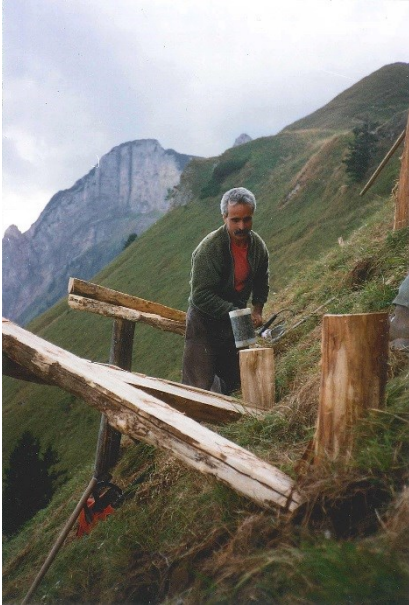
Abbildung 7: Einschlagen der Pfahlankerungen
