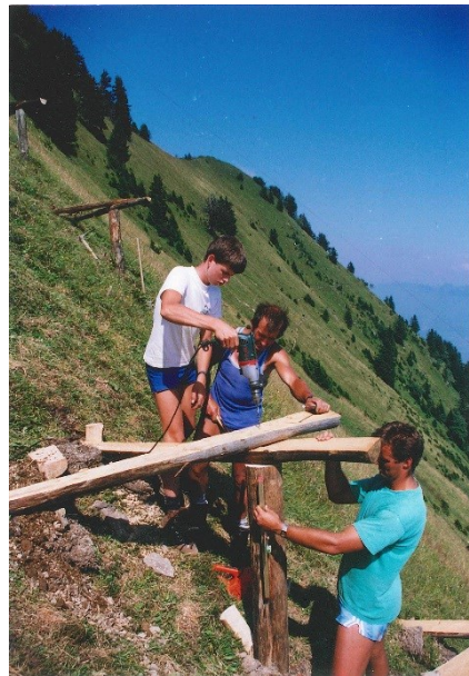
Abbildung 10: Befestigung der Träger auf der Stütze
