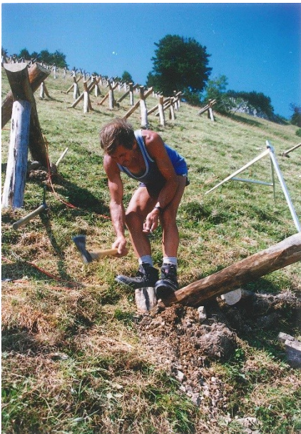
Abbildung 9: Vernagelung von Pfahl und Träger
