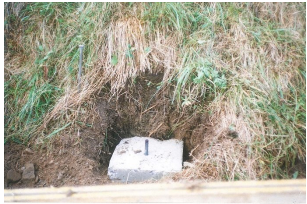
Abbildung 14: Detail Betonbodenplatte
