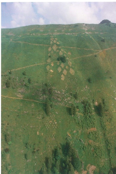
Abbildung 15: Heliaufnahme einer Verbaufäche Staubern
