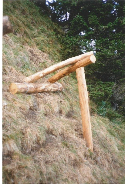
Abbildung 12: Dreibeinbock mit Schwellenverankerung
