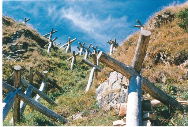
Abbildung 2: Dreibeinböcke auf felsigem Untergrund
