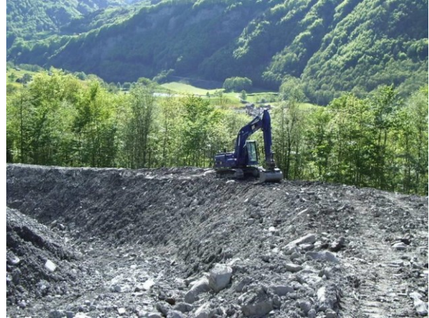
Abbildung 5 Der Leitdamm zwischen oberem und unterem Sammlerraum während der Modellierung. [3]
