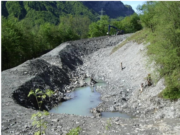
Abbildung 6 Der neue, untere Geschiebesammler mit der mit Blöcken gesicherten Überlaufsektion. [2]
