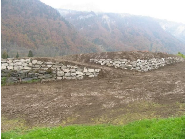
Abbildung 10 Neue Auffahrtsrampe am Schutzdamm Liesi zur Bewirtschaftung der bergseitig liegenden Wiesen (2007). [5]
