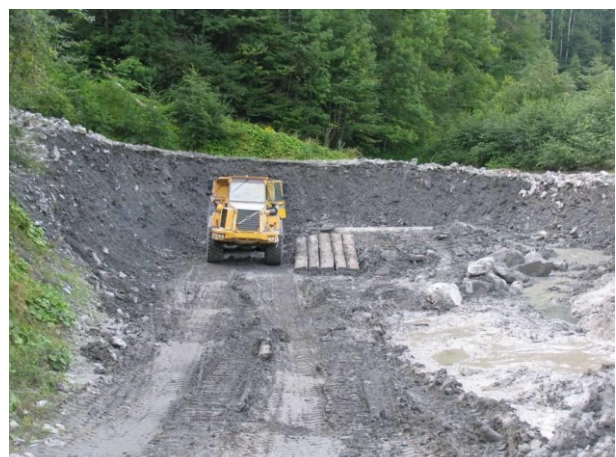
Abbildung 9 Für den Bau der neuen Schutzdämme wird ausschliesslich Geschiebe aus den beiden Sammlern verwendet.
