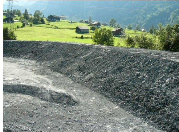
Mit Geschiebe geschütteter Damm direkt nach der Fertigstellung.
