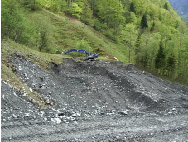
Abbildung 4 Unterer Sammler nach dem Baubeginn. Der talseitige Damm wird erhöht und eine neue Rückhalte mulde geschaffen. [2]
