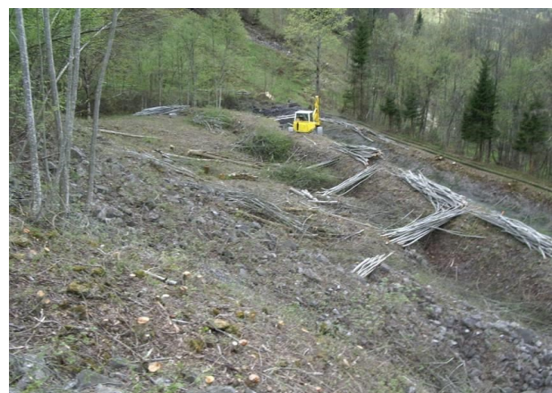
Abbildung 3 Unterer Sammler vor Baubeginn nach der Gehölzentfernung. [2]
