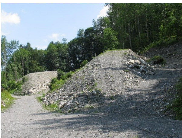
Abbildung 8 Bau der beiden Schutzdämme. Der rechte Damm kann in einer späteren Phase noch um rund 2m erhöht werden. Bergseitig fehlt auch noch eine sichernde Blocksteinmauer. [4]
