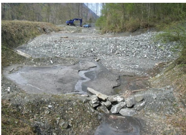
Abbildung 2 Der obere, volle Sammler vor Baubeginn (2005) [1]
