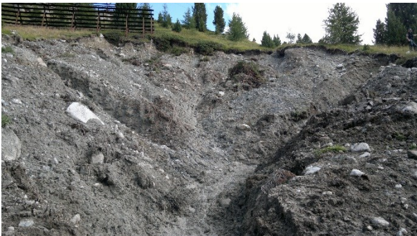
Abbildung 3: Fertig erstellte Faschinengräben
