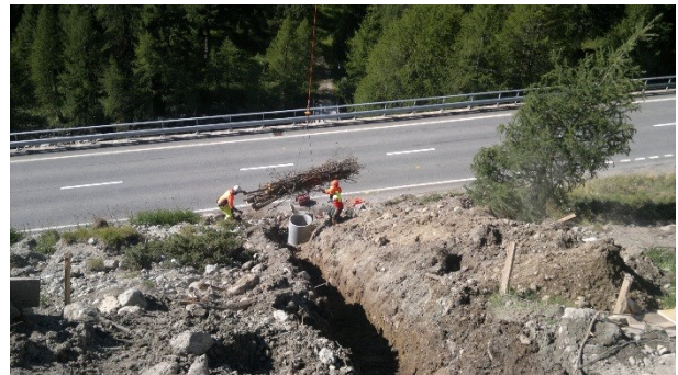
Abbildung 4: Einfliegen der Faschinen
