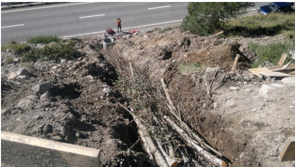
Abbildung 5: Platzierte Faschinenbunde vor dem Eindecken
