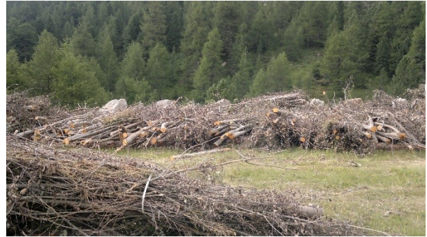
Abbildung 2: Vorfabrizierte Faschinenwalzen
