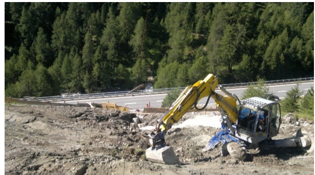
Abbildung 6: Eindecken der Faschinen
