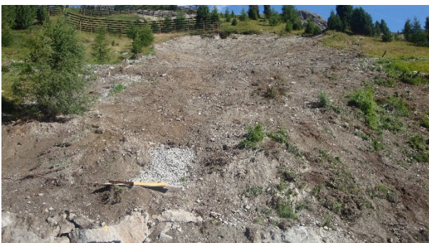
Abbildung 7: Anschluss an Entwässerungsschacht mittels Sickerpackung
