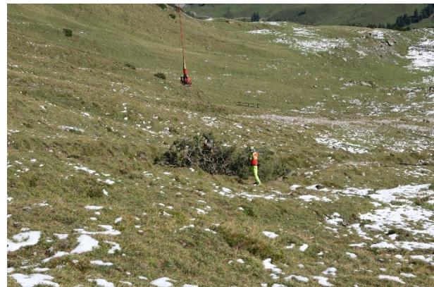
Abbildung 4: Raubäume möglichst genau im Gerinne platzieren
