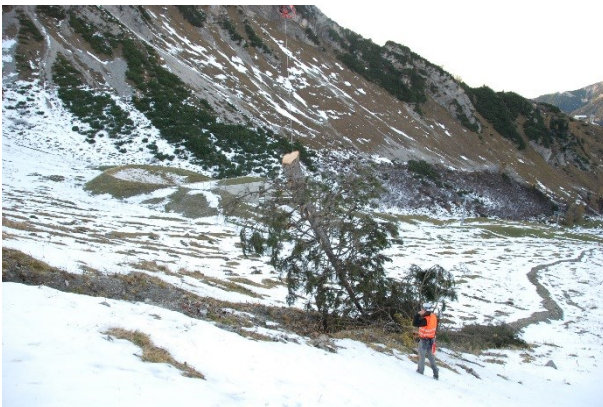
Abbildung 3: Auf genügend Überlappung der einzelnen Raubäume achten
