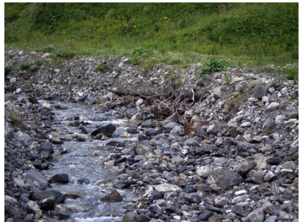
Abbildung 4: Astwerk der Raubäume armieren das Ufer
