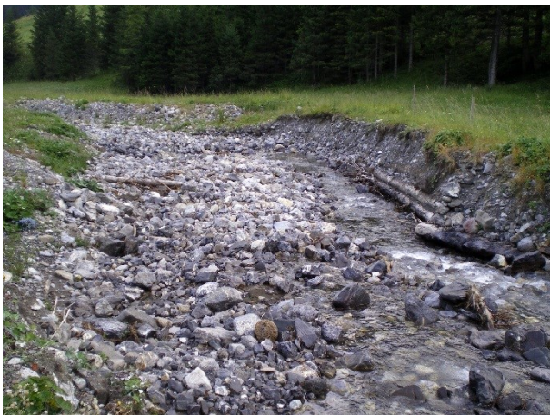
Abbildung 3: Raubaumlage hat weitere seitliche Erosion gestoppt
