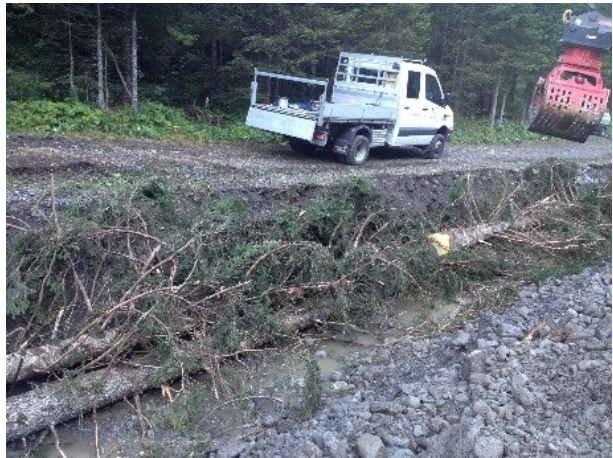
Bachufersicherung mit Raubäumen
