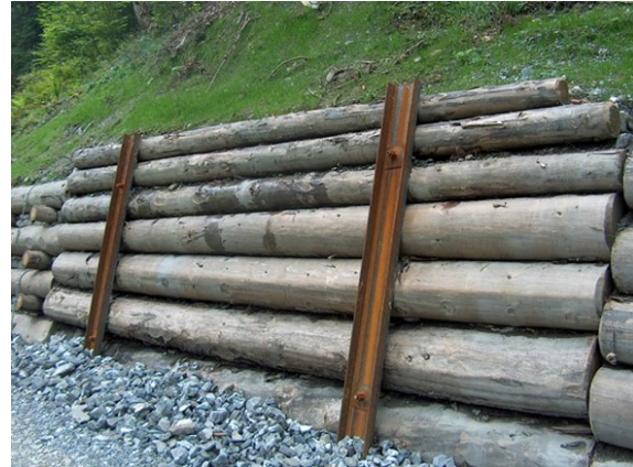
Rückverankerte Wand mit Selbstbohranker (Quelle: bap Ingenieurbüro Summaprada)
