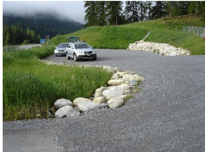
Drainage und Oberflächenentwässerung
