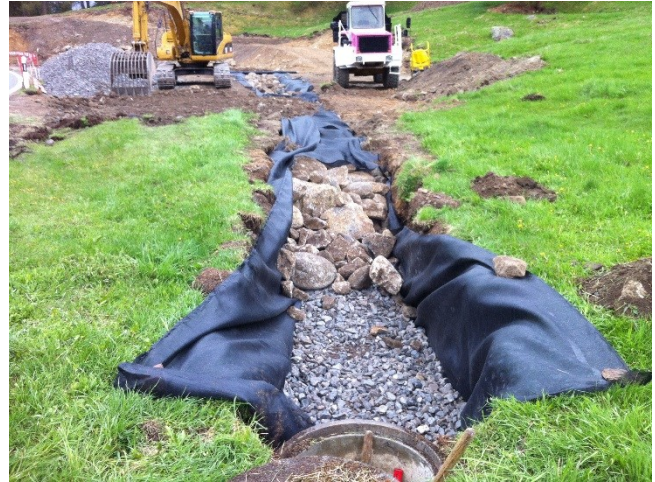
Abbildung 2 Sickerkiesumhüllung 0/32 und Überkorn 14C/400. Im Bereich der Fahrbahn mit geschlossenem Geofiltergewebe.
