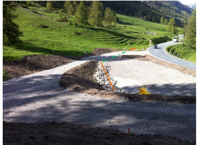
Abbildung 4 Sickerpackung offen — und verdeckt — nach der Humusierung.
