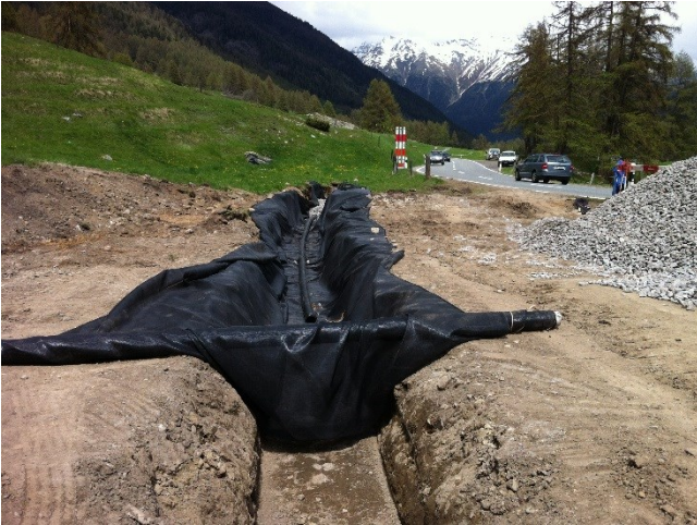
Abbildung 1 U-Graben mit Geofiltergewebe und Sickerrohr an Durchlassschacht angeschlossen
