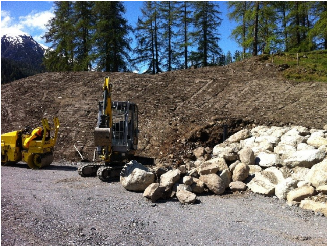
Abbildung 3 Einfüllen des Überkorns bis leicht über Terrainhöhe.
