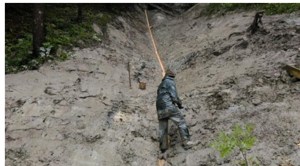
Abbildung 9: Reinigung nach erfolgtem Eindecken
