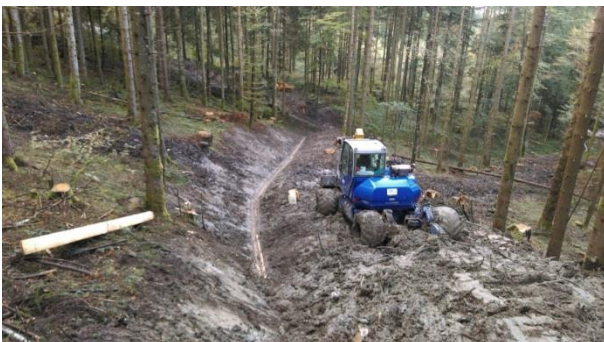
Abbildung 8: Eindecken der Kännel und Ausbildung der Böschung
