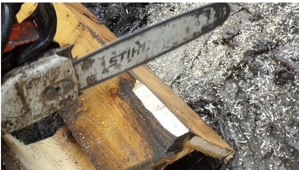
Abbildung 6: Anpassen der Kännellänge und Abkanten des talseitigen Stosses
