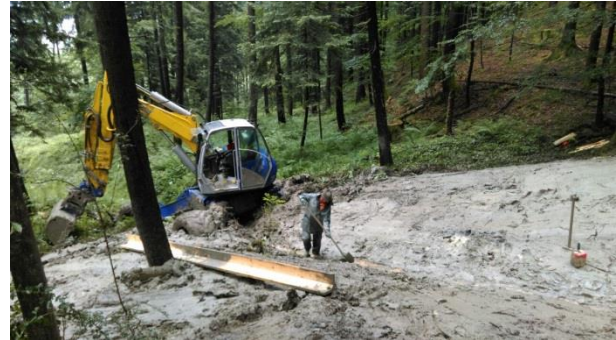
Abbildung 5: Korrektur der Neigung mit Hilfe des Baulasers
