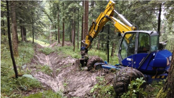
Abbildung 4: Erstellung des Grabens
