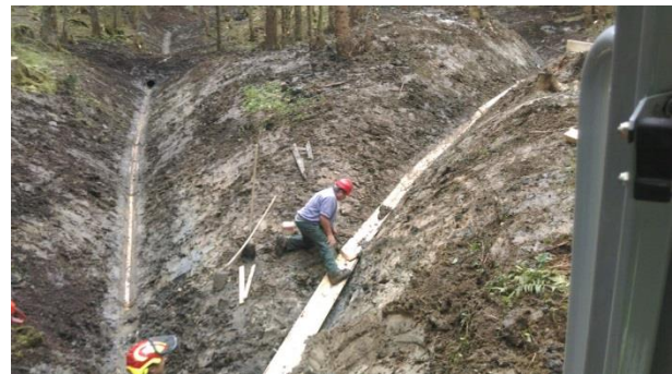
Abbildung 7: Positionieren der Kännel
