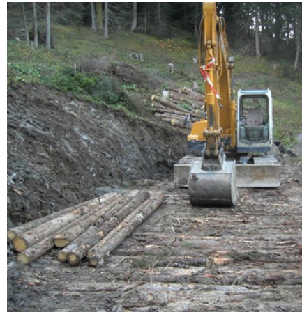
Einlage des Prügelrostes (Quelle: bap Ingenieurbüro Summaprada)
