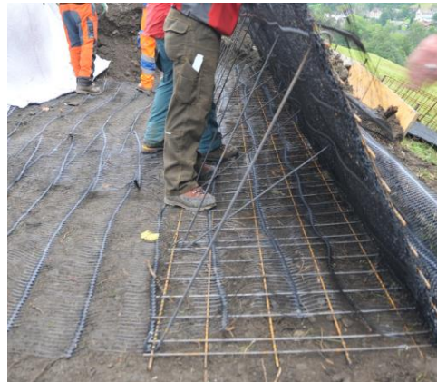
Mise en place de la structure métallique + géogridde
