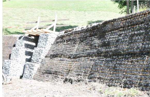
Talus stabilisé avec système de terre armée
