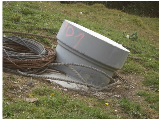
Seilkranverankerung (Quelle: bap Ingenieurbüro, Summaprada)
