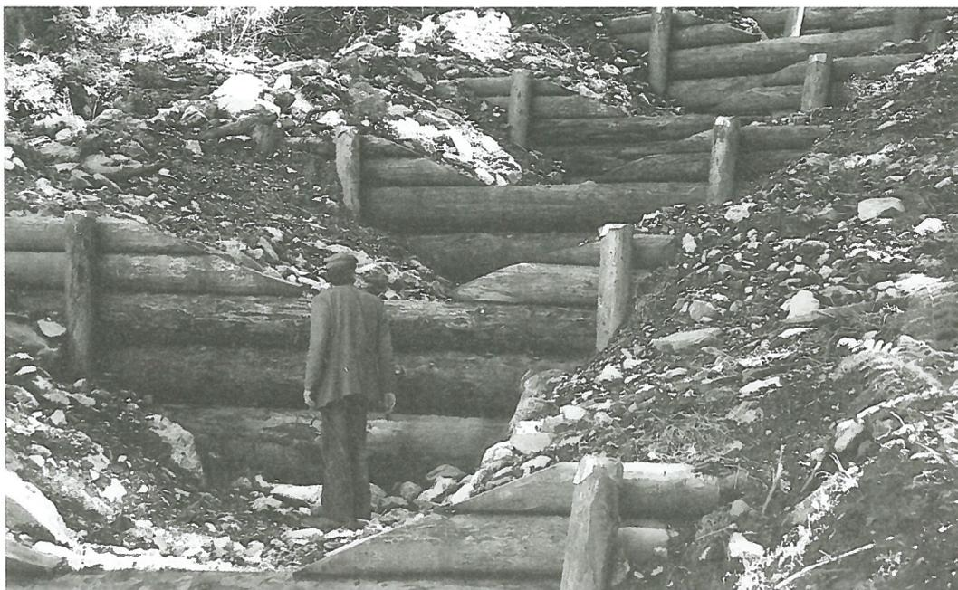
Abb. 8. Einwandige Holzsperrern kurz nach der Fertigstellung (Buochs/NW).
