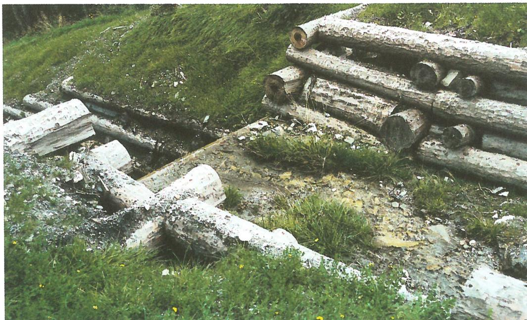
Abb. 6. Längsverbau: Verletzungen des Holzes durch maschinelle Entrindung und Probleme durch Ausschwemmungen von Feinmaterial.
