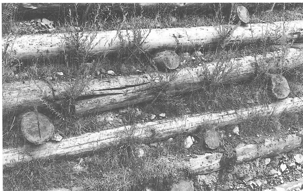
Abb. 31. Holzkasten mit gespaltenem Längsholz aufgrund nicht sachgemäss ausgebildetem Stoss, indem auf einer Seite des Stosses das Auflager fehlt.
