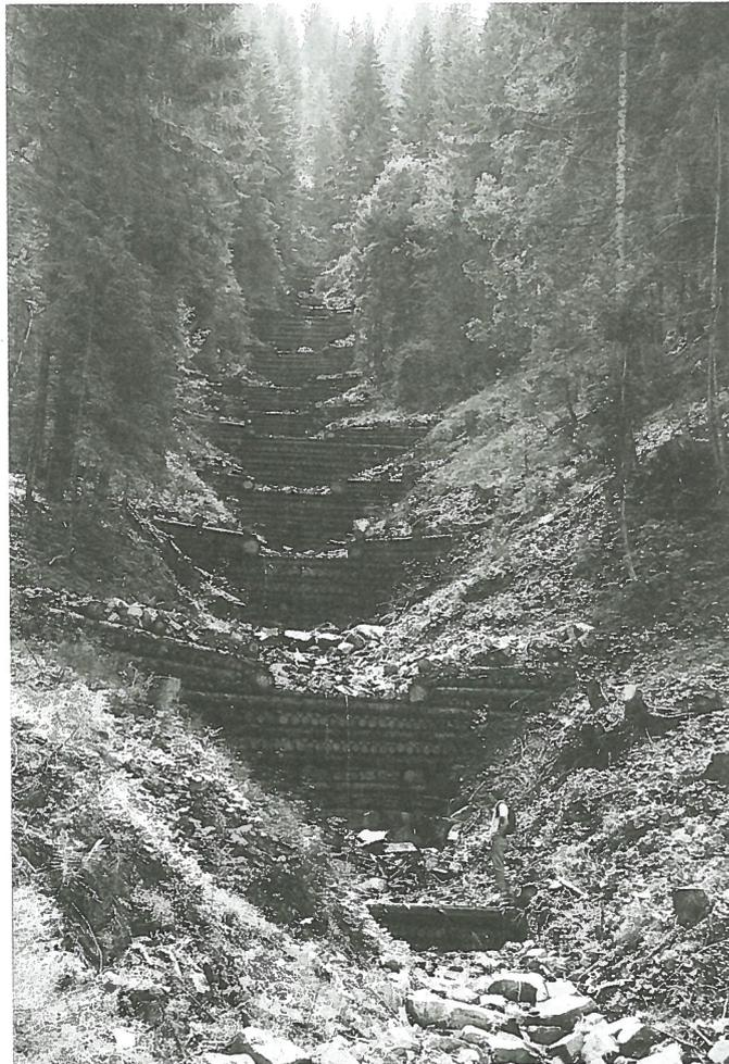
Abb. 13. Zweiwandige Holzkastensperren; Ausfachung mit Füllhölzern parallel zu den Querhölzern (Plaffeien/FR).
