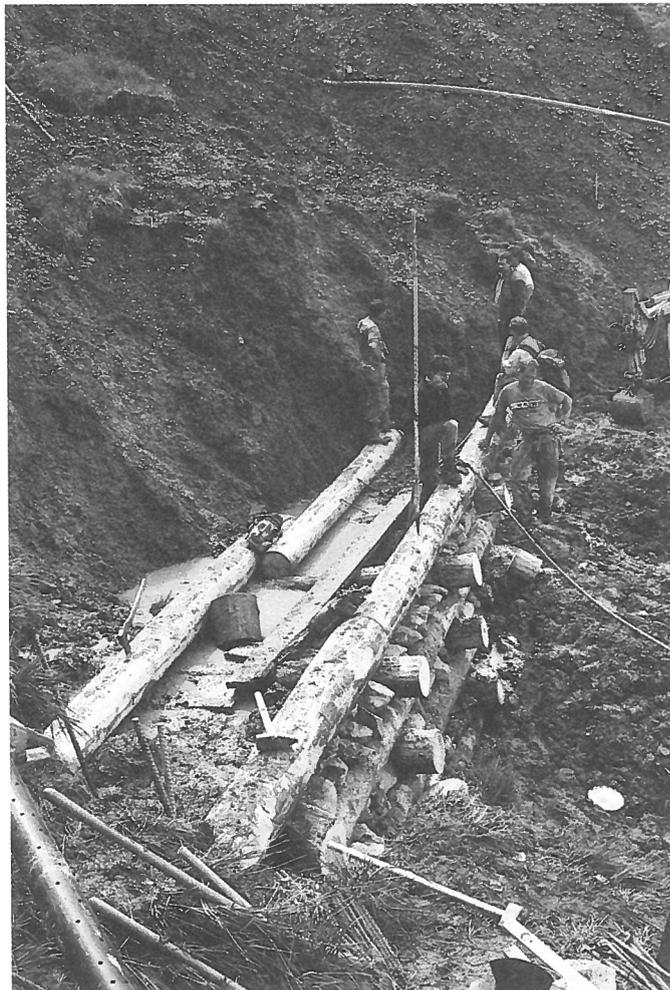
Abb. 32. Bau von Holzkastensperren in steiler Runse. Probleme mit der Wasserhaltung und nachrutschenden Böschungen.
