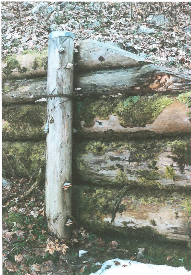
Abb. 2. *Fomitopsis pinicola* (Rotrandiger Baumschwamm) an einem Pfosten einer einwandigen Holzsperrle.
