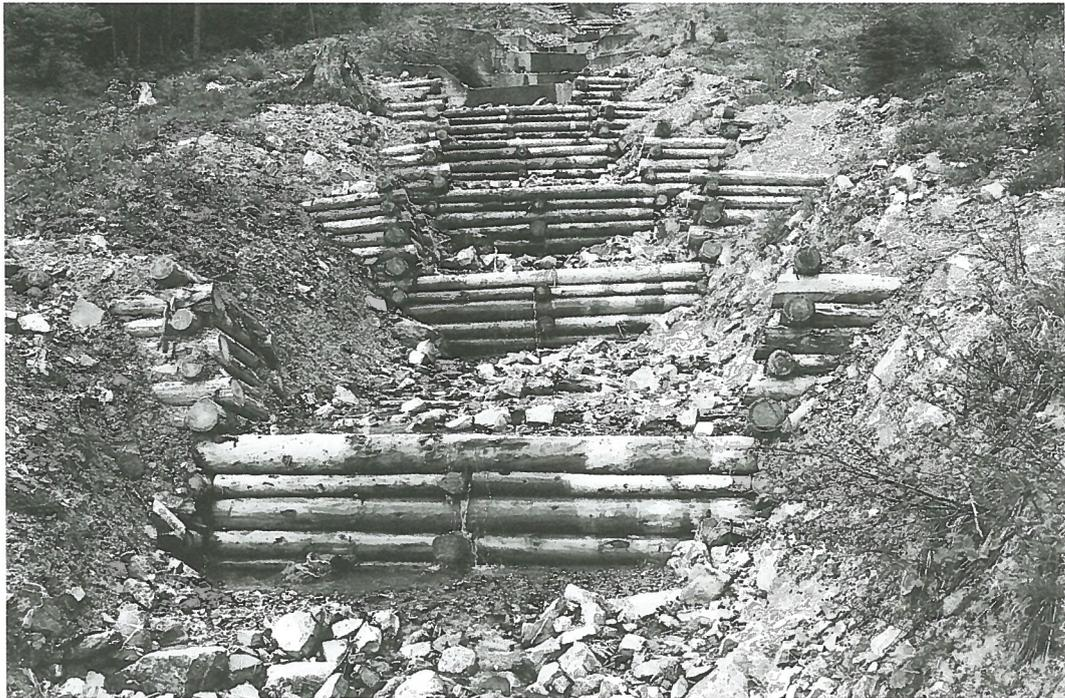
Abb. 11. Zweiwandige Holzkastensperren kurz nach Fertigstellung. Ausfachung mit Füllhölzern parallel zu den Längshölzern (Studen/SZ).
