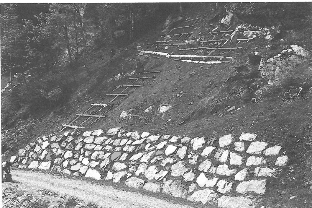
Abb. 17. Rutschsanierung: Stützmauer aus Steinblöcken, Holzkästen und Hangrost (Elm/GL).
