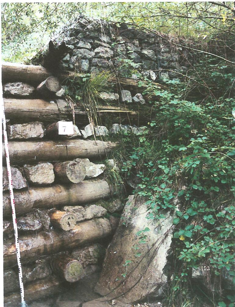
Abb. 4. Holzabbau durch Pilze im Bereich der seitlichen Einbindung einer Wildbachsperre.
