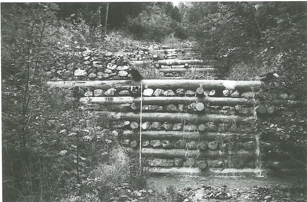
Abb. 10. Zweiwandige Holzkastensperren mit Steinausfachung und Flügeln aus Drahtsteinkörben (Gams/SG).
