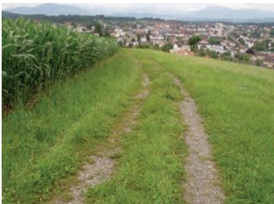
*Der frostsichere Kieskoffer ist zu stark überwachsen.*
