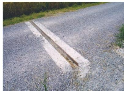
*Querschläge während und nach heftigen Niederschlägen prüfen und bei Bedarf reinigen.*
