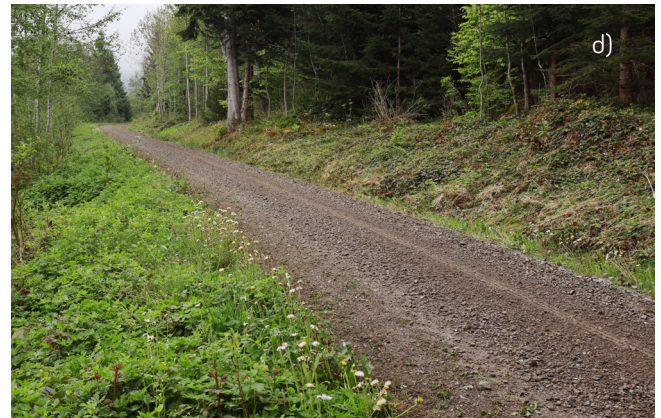
Abbildung 4: Strassenabschnitt im (a) Ausgangszustand, (b) nach Materialgewinnung rechts, (c) Materialgewinnung links mit hohen, aber noch verträglichen organischen Anteilen und (d) der Verteilfahrt mit höherer Fahrgeschwindigkeit.
