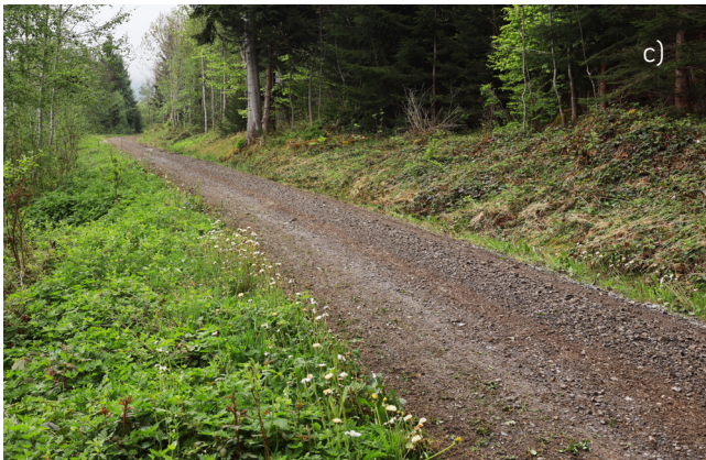
Abbildung 4: Strassenabschnitt im (a) Ausgangszustand, (b) nach Materialgewinnung rechts, (c) Materialgewinnung links mit hohen, aber noch verträglichen organischen Anteilen und (d) der Verteilfahrt mit höherer Fahrgeschwindigkeit.
