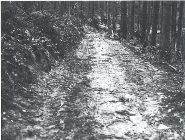
Abb. 33. Maschinenweg kurz nach dem Bau – bergseitige «Böschung» nicht abgeflacht.
