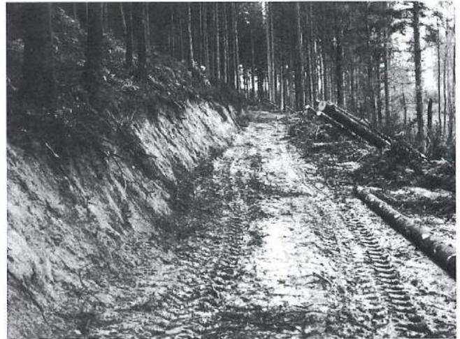
Abb. 34. Teilstück des gleichen Maschinenweges in steilerem Gelände. Bergseitige höhere Böschung zur Verminderung der Abwitterung abgeflacht.
