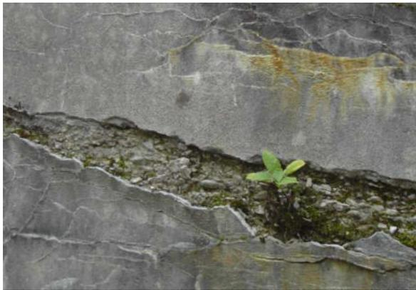
Bewuchs nach eines Betonbauwerks entlang einer Abplatzung (SKL U) ©Suda
