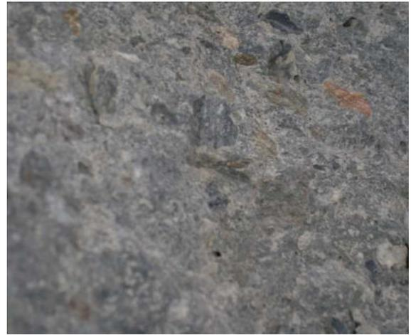
„Waschbeton“ durch Erosions- und Abrasionsgeschehen
