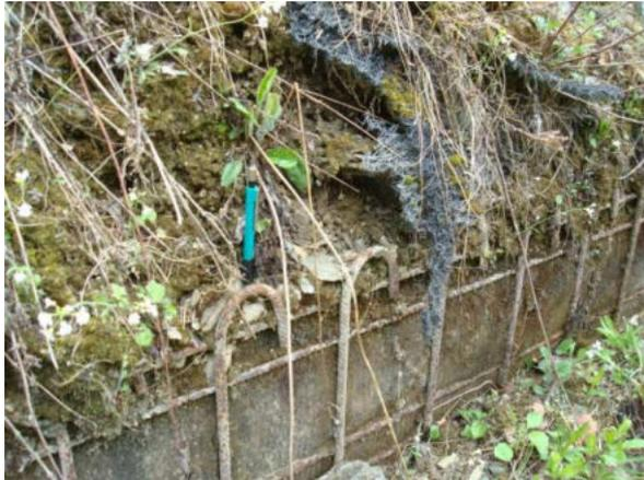
Abtrag der Füllung infolge einer Beschädigung des Drahtgeflechts (SKL K) ©WLV Geologie
