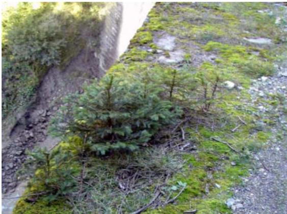
Bewuchs durch Jungbäume (Wurzeln sie in angewehetem Substrat oder in den Mauerwerksfugen?); Fugenzustand darunter überprüfen ©Suda
