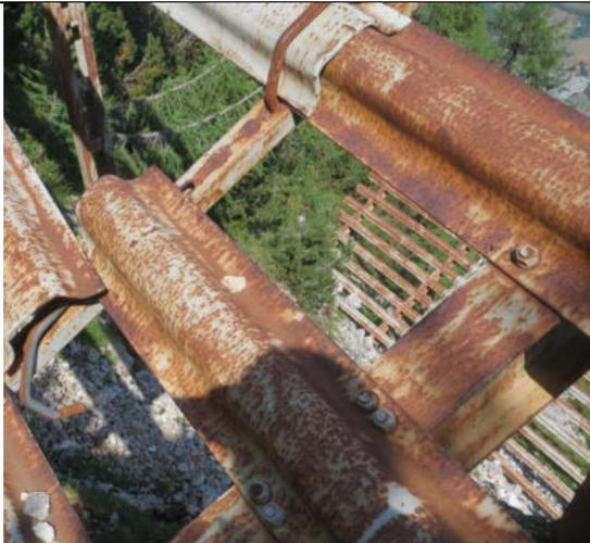
Korrosion an Stahlschneebrücken (SKL U) © WLV Kärnten
