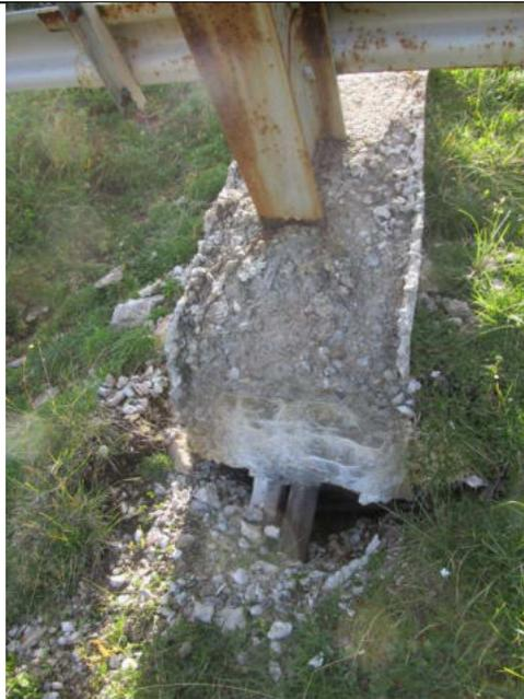
Erosion- und Abrasion an Stützenfundament (SKL K)
