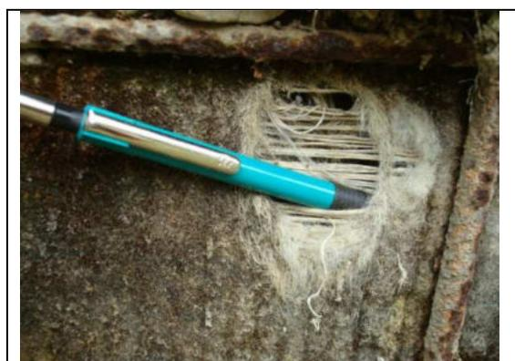
Schaden am Geotextil (SKL K) ©WLV Geologie
