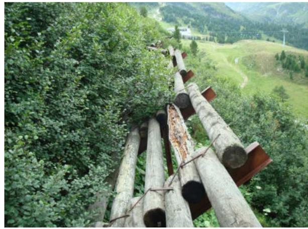
Verwitterung nach Beschädigung der Holzbedielung (SKL K)
