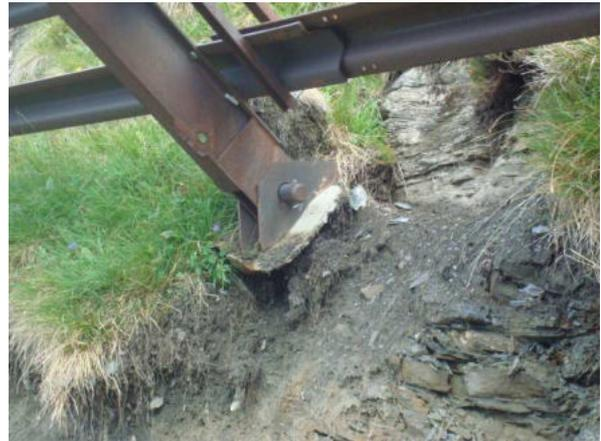
Freigelegte und Deformierte Stützenplatte (SKL K) ©WLV
