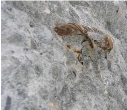
Freiliegende Bewehrung durch Abrasion ©WLV
