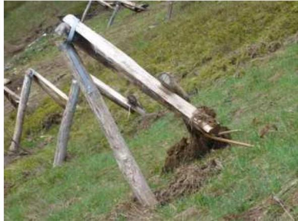
Überlastungsschaden an Stahlnägeln
