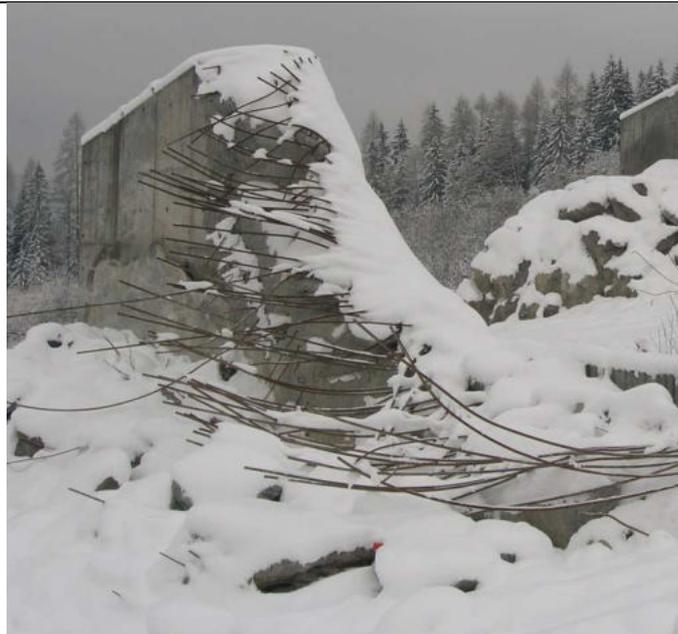
Betonabrasion mit Freilegung der Bewehrung (SKL H) © WLV
