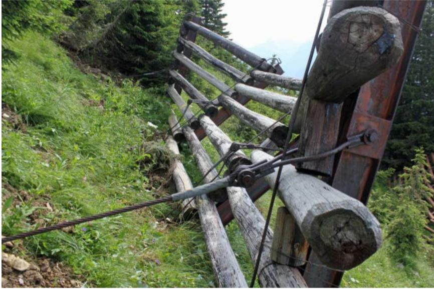
Schadhafte und gerissene Abspannungen (SKL H) ©WLV Bludenz
