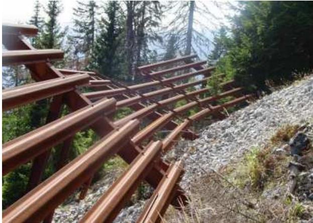
Bauwerksbewegung durch Stützenplattenversagen
