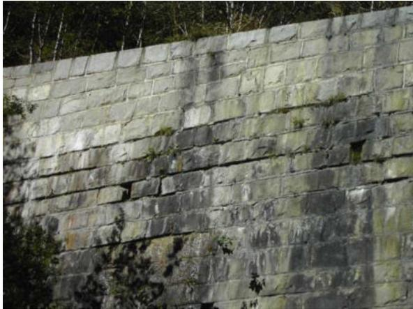
Durchfeuchtungen und Pflanzenbewuchs deuten auf eine Schädigung des Mauerkörpers durch Verwitterung hin, lokal fehlender Fugenmörtel (SKL U)©Suda
