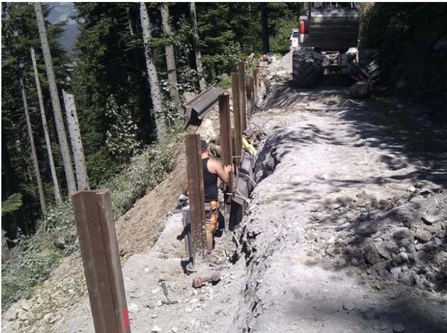
Abbildung 56 Setzen der Pfähle (SBB) und vorbereitete, rückhaltende Spiralseilanker für eine rückverankerte Pfahlwand (Ribbert AG).
