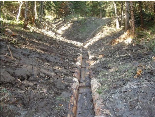
Abbildung 24 Rundholz-Rechteckkännel 40/25 nach Zeller/Trümpler 1984 (Lieberherr M.)
