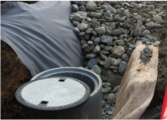
Abbildung 37 Ein Kontrollschacht muss für die Kontrolle und Spülung mindestens einen Durchmesser von dn600 aufweisen. Ab einer Schachttiefe von über 1.3 m reicht dies nicht mehr (AWN GR).
