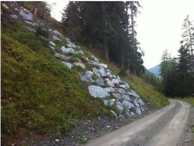
Abbildung 60 Rollierung einer instabilen Wegböschung. Die Blöcke/Steine sind in Hangneigung kraftschlüssig gesetzt (AWN GR)
