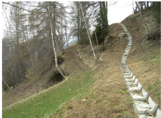
Abbildung 23 Polymerbeton-Sohlschalen (Wildbachschalen) zur verlustfreien Wasserableitung (bap Ing.).
