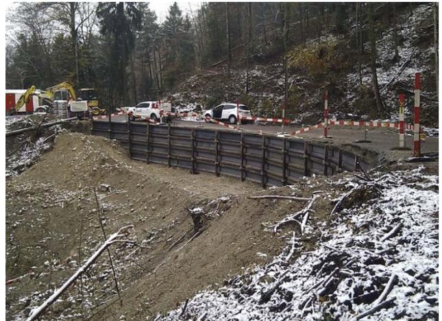
Abbildung 57 Rückverankerte Pfahlwand nach der Fertigstellung (Ribbert AG)
