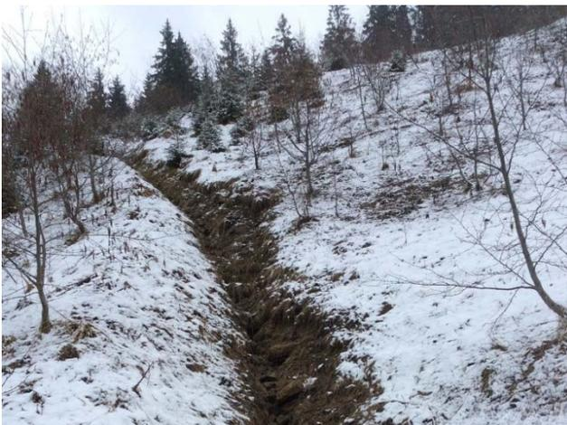
Abbildung 22 Offener V-Profil Graben zur Entwässerung des Geländes.
