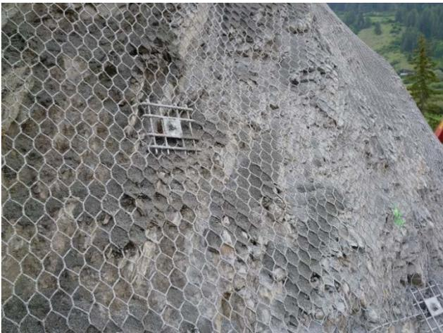
Abbildung 64 Ankerraster (Nägel) und Netzabdeckung vor der Begrünung (fobatec).
