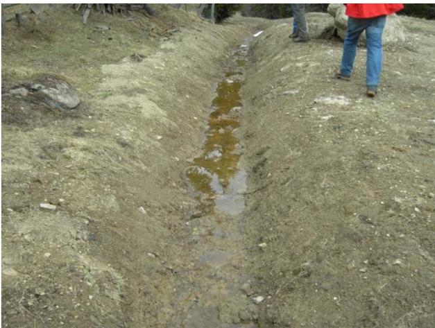
Abbildung 34 Mit Bentonit-Matten abgedichteter Entwässerungsgraben zur kontrollierten Ableitung von Oberflächenwasser (bap Ing.)
