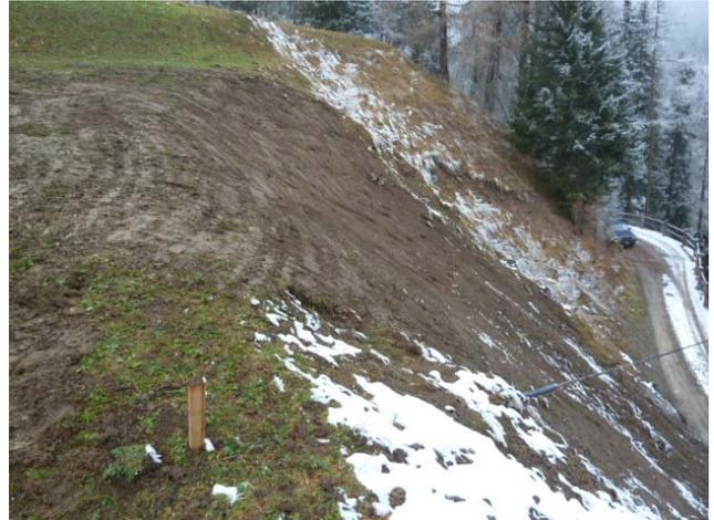
Abbildung 63 Der fertiggestellte Hangrost ist vollständig eingedeckt und bleibt so am längsten funktionstüchtig (AWN GR).
