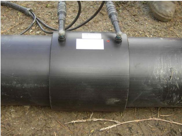
Abbildung 29 PE Rohr mit Heizwendel-Schweissmuffe zur Verschweissung angeschlossen (bap Ing.).
