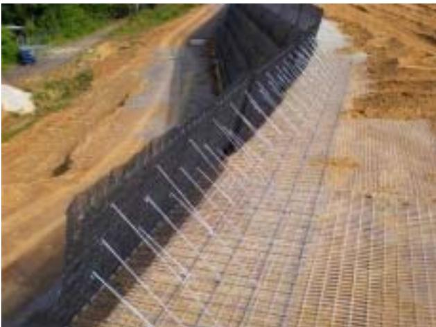
Abbildung 50 Das Konzept der bewehrten Erde bildet einen in sich stabilen Block, der mit seinem Gewicht dem bergseitigen Material entgegenwirkt (nackten-steisslingen.de)
