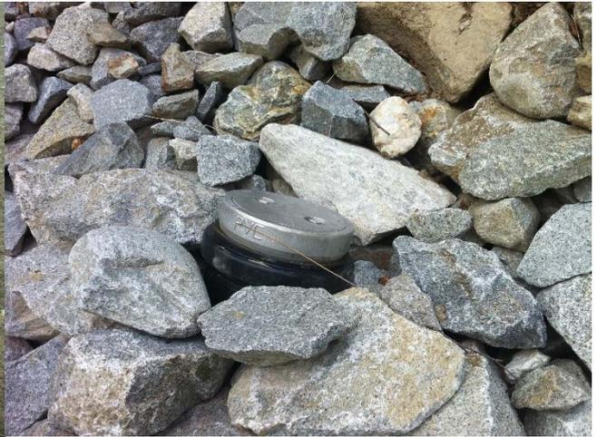
Abbildung 40 Sauber verschlossener und geschützter Spülstutzen (AWN GR).
