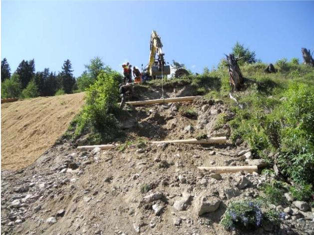
Abbildung 54 Oberflächenbefestigung durch rückverankerte Schwellen (AWN GR).
