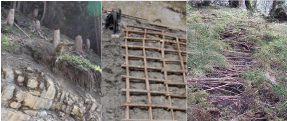
Abbildung 70 Situationen in welchen die Wurzelverstärkung durch die drei Hauptmechanismen wirkt: basale Wurzelverstärkung (Links), Erhöhung Steifigkeit und passiver Erddruck (wie bei einer Hangrost, Mitte) und laterale Wurzelverstärkung (Rechts).
