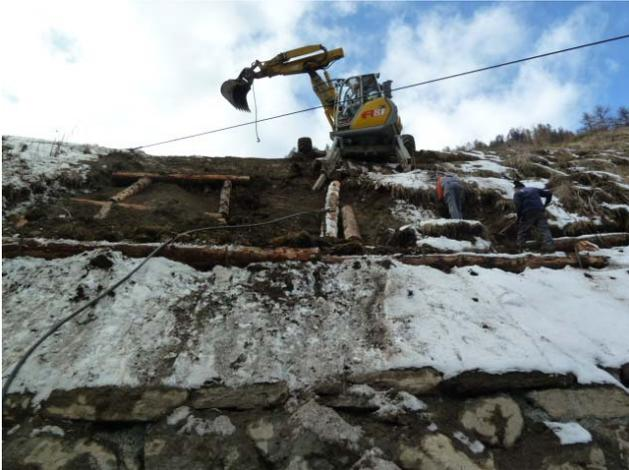
Abbildung 62 Auf einer Mauer abgestützter Hangrost im Bau (AWN GR).
