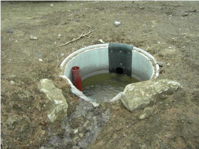
Abbildung 39 Bei Verrohrung von offen geführtem Wasser ist vorgängig ein unterhaltstaugliches Absetzbecken einzurichten (bap Ing.)
