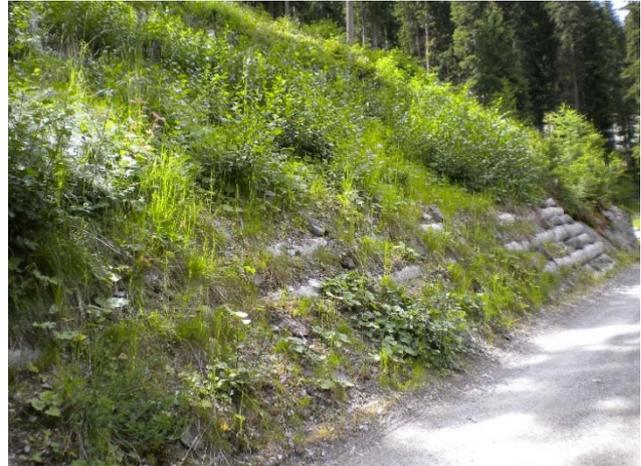
Abbildung 49 Durch Eindeckung und Erstellung in Hangneigung ist ein Holzkasten als Stützkonstruktion langlebig und kann Bewegungen mitmachen (AWN GR).
