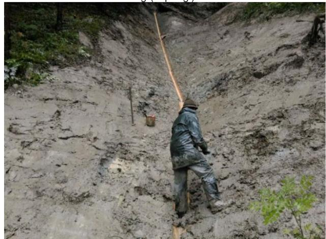
Abbildung 25 Graben mit Holz-V-Kännel 20/4 nach Zeller/Trümpler 1984 (Lieberherr M.)
