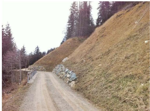
Abbildung 44 Dank Materialabtrag ist die Böschung flacher und ihre Tragsicherheit gegeben. Ohne Abflachung wäre eine deutlich höhere Stützmauer nötig gewesen (AWN GR).
