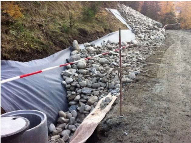
Abbildung 27 Sickerpackung mit Geotextil (Filtern/Trennen) gegen Berg und Geotextilabdichtung (Bentonit) am Grund und gegen den Strassenkörper sowie ein Kontrollschacht (AWN GR).
