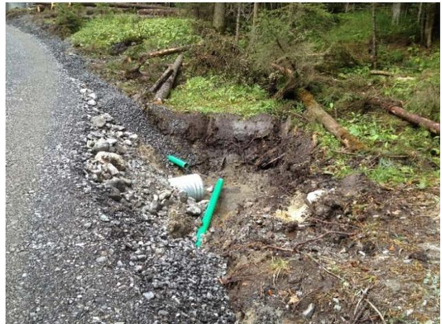
Abbildung 28 Klassische Sickerleitung mit PP S, dn 160, mit Sickerkies 32/50, ausgeführt ohne Geotextil. Sichtbar als Auslauf und als Spülstutzenende vor Realisierung des Einlaufbauwerkes einer Strasse (AWN SZ).
