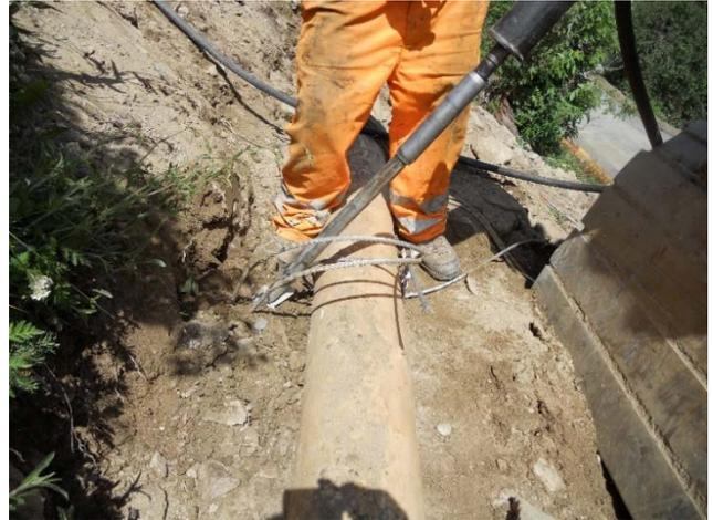
Abbildung 55 Eintreiben des Erdankers mit dem Kompressor und Gestänge mit anschliessendem Festsetzen durch Ausziehen bis zum Halt (AWN GR).
