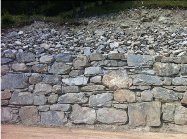
Abbildung 48 Bei Stützmauern aus Blöcken und Bruchsteinen mit natürlichen Kanten sind Form- und Kraftschluss wichtig. Eine Vermörtelung unterstützt den Kraftschluss und ist ab ca. 3m Höhe sinnvoll (AWN GR).
