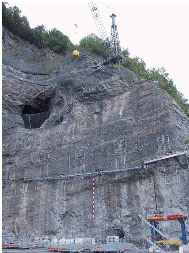
Abb. 6-5: Versuchsanlage Lochezen, Walenstadt SG, mit montiertem Schutznetz, Wurfkörper und Krananlage.
