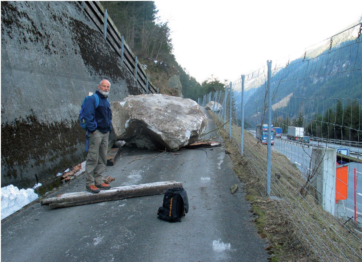
Abb. 3-7: Dieser Block durchschlug die Palisadenwand aus Holz und blieb danach auf der schmalen Strasse liegen (Wilerwald, Gurnellen UR).
