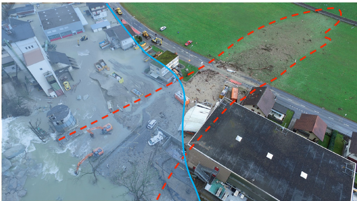
Abb. 4-11: Spuren der Schäden bis zur Bahnlinie. Blau markiert sind die Überschwemmungsschäden und rot die Steinschlagschäden. (Foto: ZSO EMME am 12.1.2016).
