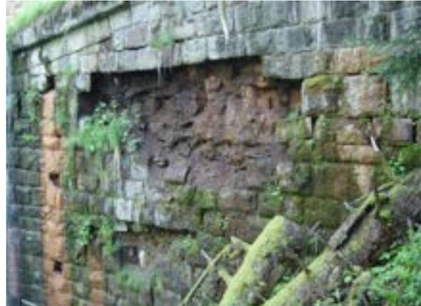
Abgeplatzte oberste Steinschicht bei Mischmauerwerk (SKL H) ©WLV
