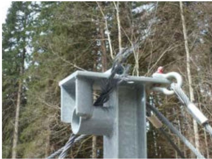
Beschädigtes Tragseil ©WLV Geologie
