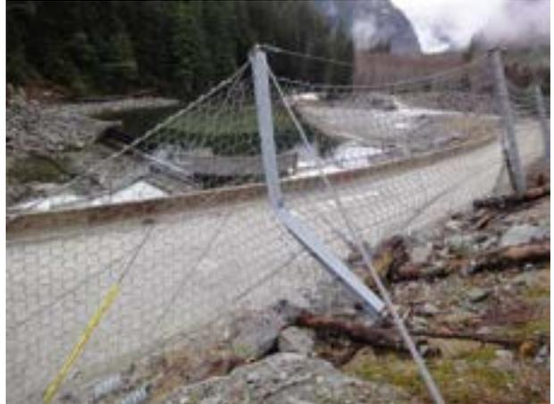
Deformierte Stütze durch direkten Einschlag (SKL K)
