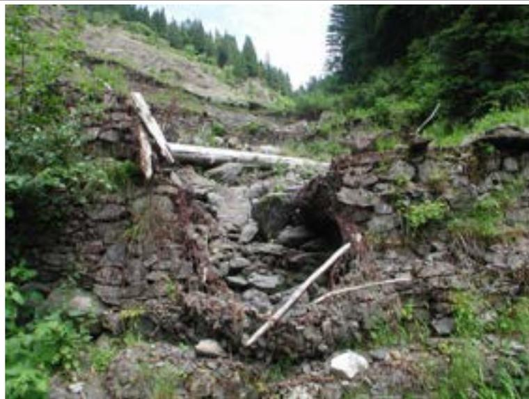
Abtrag der Füllung infolge einer Beschädigung des Drahtgeflechts (SKL H) ©Suda
