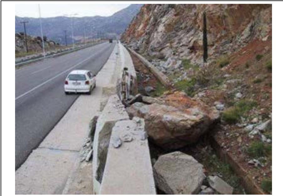
Riss und Bruch einer Betonmauer infolge eines Steinschlags (SKL H) ©Geobruigg
