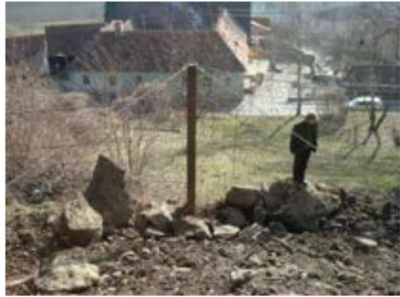
Reduzierte Wirkhöhe durch Ablagerungen vor dem Netz ©WLV Geologie
