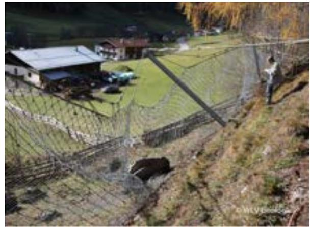
Reduzierte Wirkhöhe durch Ablagerungen im Netz ©WLV Geologie
