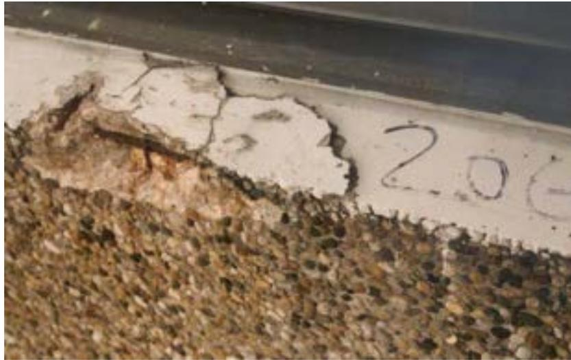
Absprengung der Überdeckung durch korrodierende Bewehrung (SKL K)
