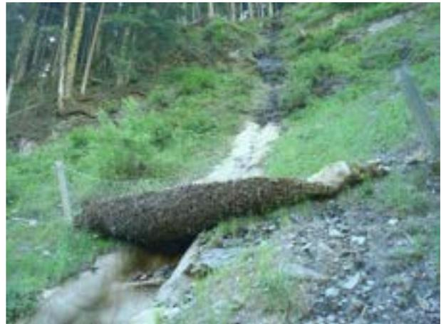
Verkläusung am Steinschlagnetz ©WLV Geologie
