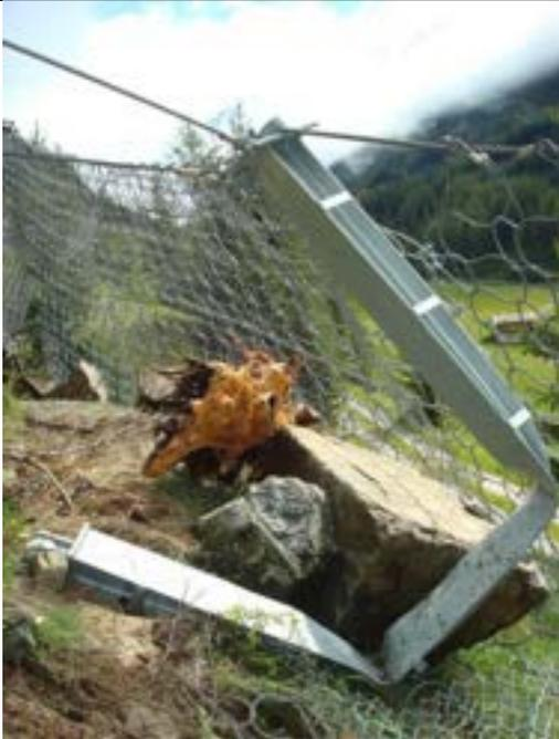
Deformierte Stütze durch direkten Einschlag (SKL H)
