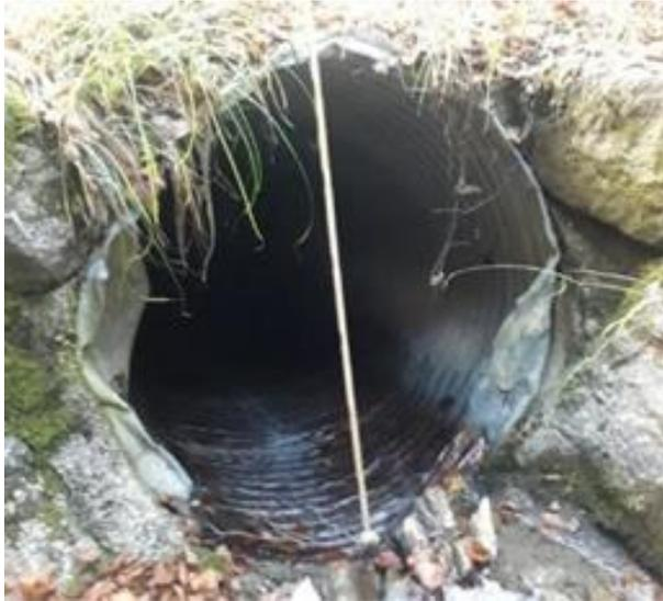
Illustration 9 : Aqueduc en acier ondulé DN 1300
