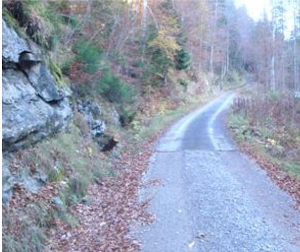
Illustration 21 : La transition entre revêtement naturel et bitume est idéalement réalisée avec une rigole transversale
