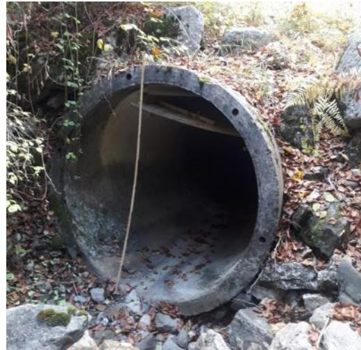
Abbildung 6: Zementrohrdurchlass DN 1000
