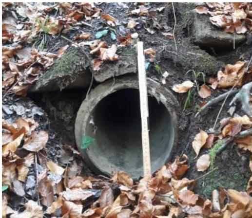
Abbildung 7: Zementrohrdurchlass DN 300
