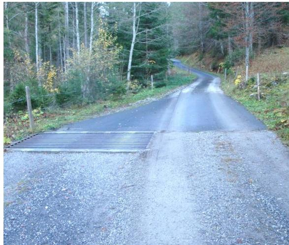
Abbildung 22: Oberbauwechsel zu Grundwasserschutzzone mit Weiderost
