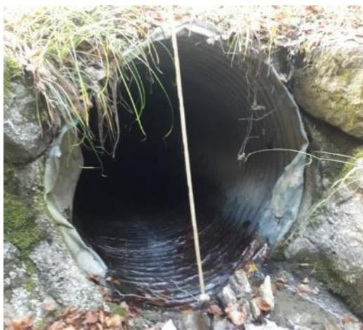
Abbildung 9: Wellstahldurchlass DN 1300
