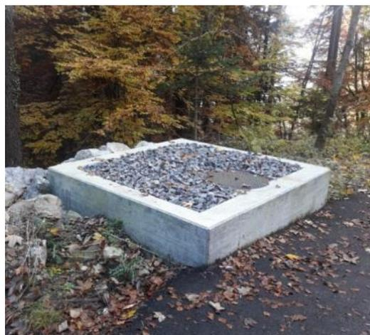
Abbildung 10: Quellwasserfassung (Brunnenstube) in Schutzzone S1
