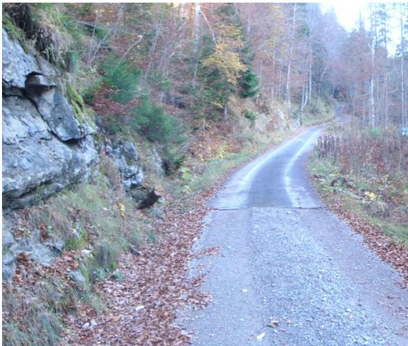
Abbildung 21: Wechsel von Naturstrasse zu Asphaltbeton wird am besten mit einem Querabschlag aus Metall abgegrenzt
