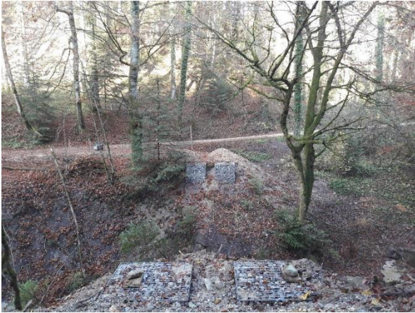
Vorbereitete Steinkorb-Widerlager Culées en gabions
