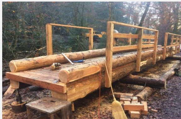
Abb. 1 Vorbereitete Rundholzbrücke (Quelle: Gemeinde Montagny)
