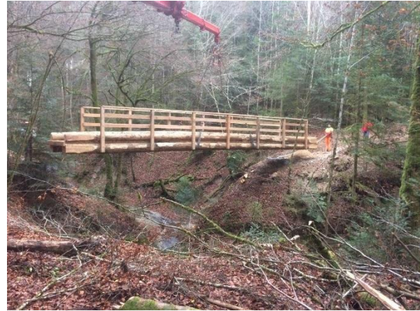
Installation der Brücke mit LKW-Kran Pose de la passerelle avec camion-grue
