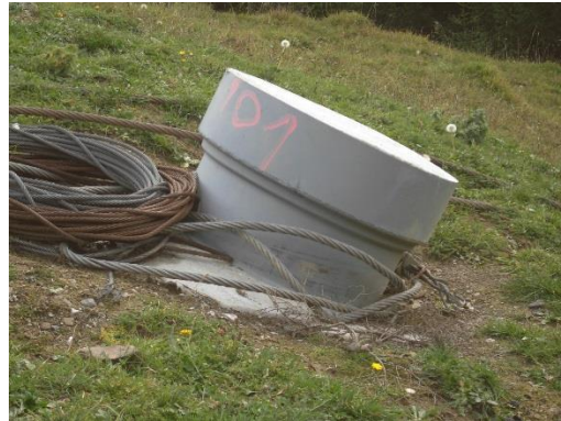
Seilkranverankerung (Quelle: bap Ingenieurbüro, Summaprada)
