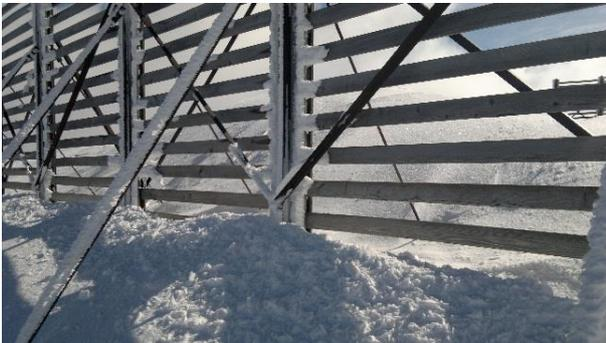
Abbildung 2: Mit den Trägern verschweisster Windverband (Diagonalstreben)
