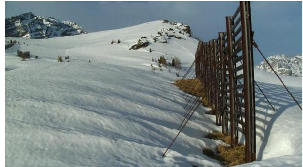
Abbildung 3: Seitliche Zug-/Druckstreben Gewi-Stab Ø 25 mm
