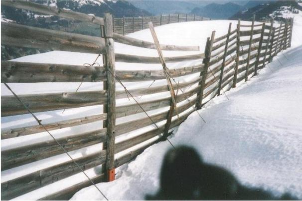
Abbildung 1: Beschädigter und nun ersetzter Triebsschneezaun aus den 80er Jahren
