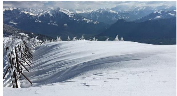
Abbildung 5: Der Düseneffekt des Bodenspaltes verhindert ein Einschneien des Triebsschneezaunes
