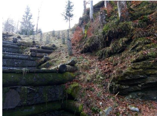
Abb. 6 (oben): Die Verbauung Jahre nach der Fertigstellung (Bild: M. Nyfenegger).
