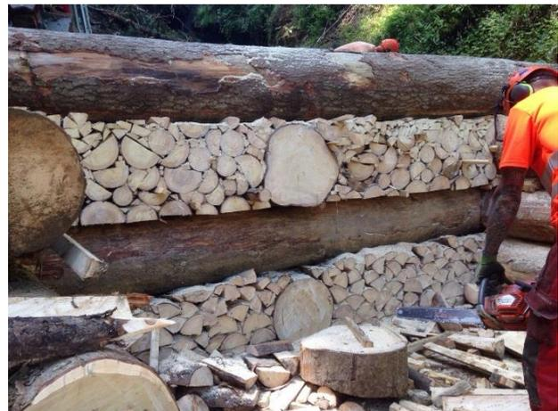
Abb. 4 (oben): Die Holzscheite für die Ausfachung werden mit der Motorsäge zugeschnitten.
