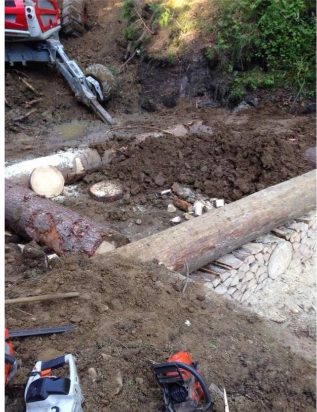
Abb. 2: Die Verfüllung wird wie üblich mit Aushubmaterial und Holzresten eingebaut.
